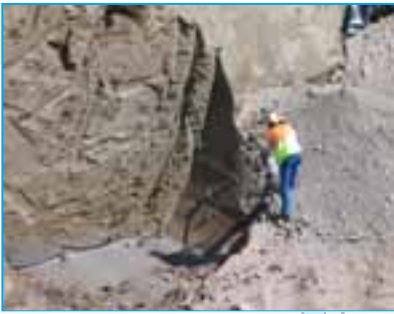
Maaperän kunnostustyöt ovat usein mittavia, runsaita maansiirtoja vaativia ja kalliita ympäristön parannustoimia
