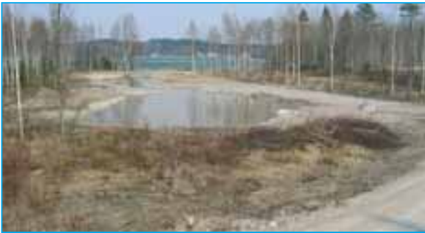
Kariston alueen rakentamisessa pyritään estämään hulevesistä Kymijärveen aiheutuvat rehevyyshaitat laskeutusaltaita ja kosteikkoja rakentamalla.
