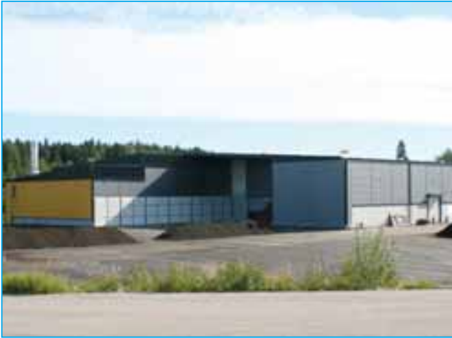
Kujalan kompostointilaitoksessa käsitellään 100 000 asukkaan biojätteet ja 170 000 asukkaan puhdistamolietteen. Niistä valmistetaan maanparannuskompostejä ja kasvulaustoja.
