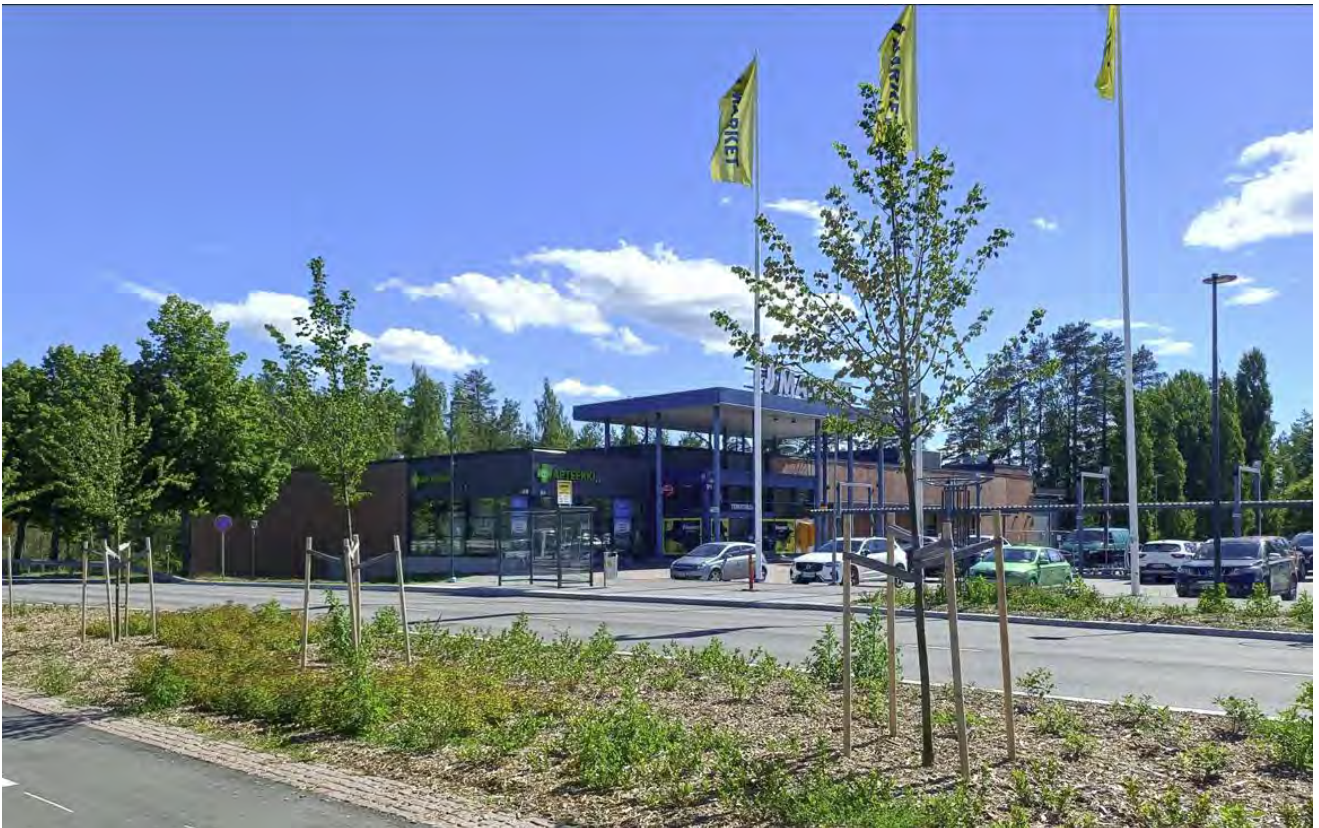
Kuva 14 Rakokiven S-marketin punatiilinen liikerakennus sijaitsee Rakokiventien eteläpuolella suunnittelualueen länsipuolella. Sotepe-keskuksen lähin joukkoliikenteen pysäkki sijaitsee S-marketin edustalla.
