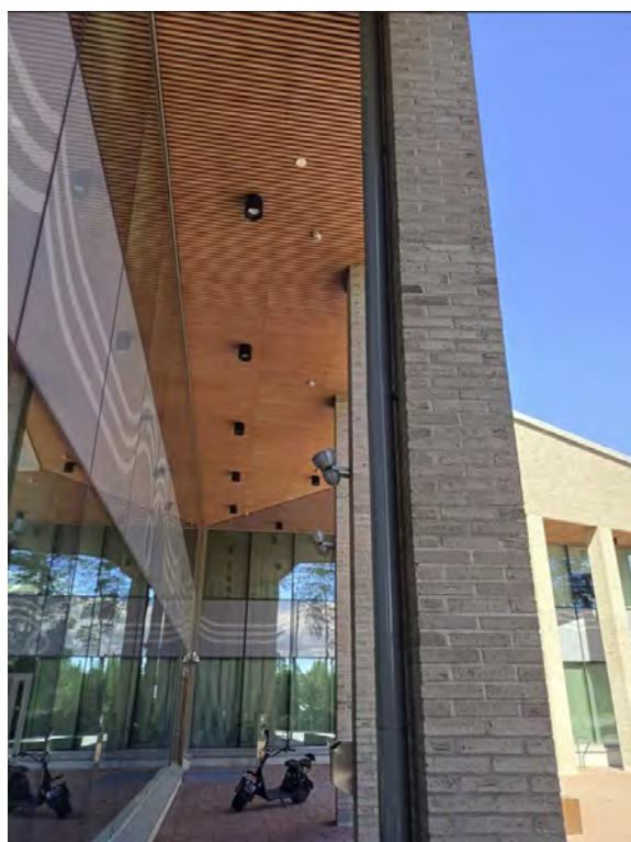
Kuva 19 Monitoimitalo-Loiston puuyksityiskohtia pääsisäänkäynnin yläpuolella.
