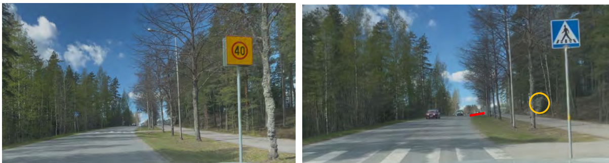
Kuva 3. Lähestymisen Rakokiventietä idästä toukokuussa 2026. Vasemman kuvan kuvauspaikasta on matkaa tonttiliittymään noin 80 m ja oikeanpuoleisesta kuvasta noin 50 m. Tonttiliittymän paikka on merkitty oikeanpuoleiseen kuvaa punaisella viivalla. Oikeanpuoleisessa kuvassa oranssilla ympyrällä on merkitty tontin rajalla oleva iso siirtolohkare, joka jää osittain tonttiliittymän ja pyörätien näkemäalueelle ja on syytä siirtää liittymän toteutuksen yhteydessä.
