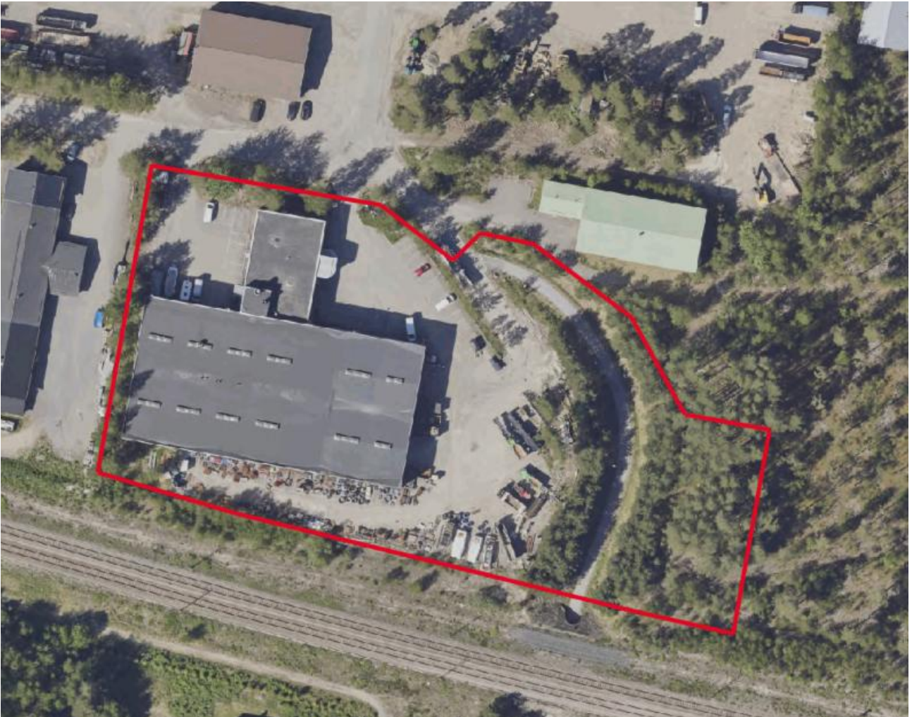
Varikontie 9, kaavamuutosalue. Ortoilmakuva on vuodelta 2024. Sen jälkeen tontti on siistiytynyt pihalla olevista konteista ja tavaroista.
