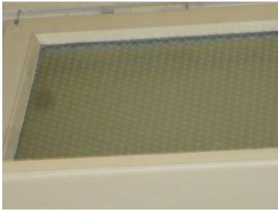
Kuva 25. Julkisivuremontissa umpeen levytetty alkuperäinen yläikkuna.
