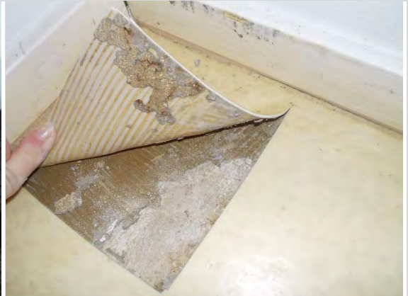
Kuva 46. Asuntosiiiven välipohjan lattiapäällysteen alla olevia tasoite- ja liimakerroksia
