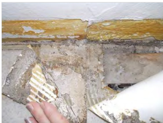
Kuva 9. Luokka 1095 (05) alapohjarakenteessa on useita tasoite ja liimakerroksia, sekä puukappaleita
