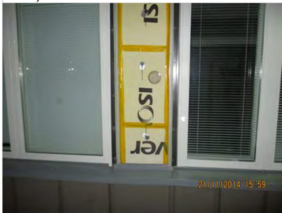
Kuva 27. Ikkunoiden väli avattuna korjatussa julkisivussa.
