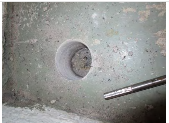
Kuva 8. alapohjan(varastotila) rakenneavaus, jossa on bitumisivelyeristys näkyvissä.
