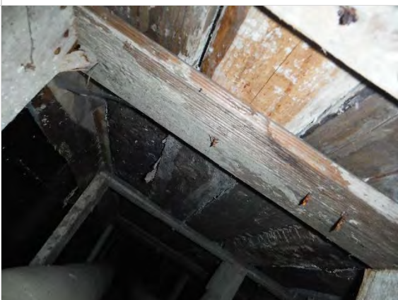
Kuva 14. Näkymä kanaaliin sisälle luukun kautta kuvattuna.
