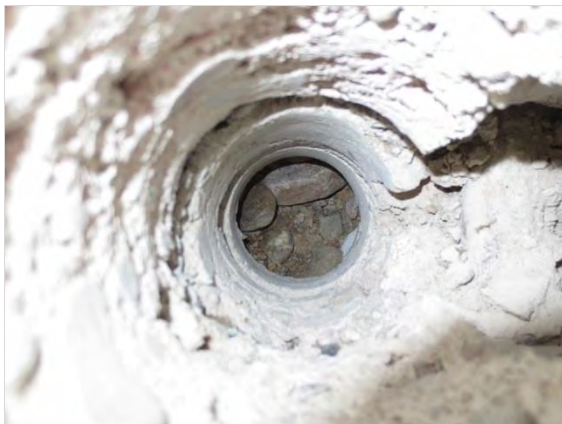
Kuva 7. Pääaulan alapohjan rakenneavaus pohjatäyttöön saakka.
