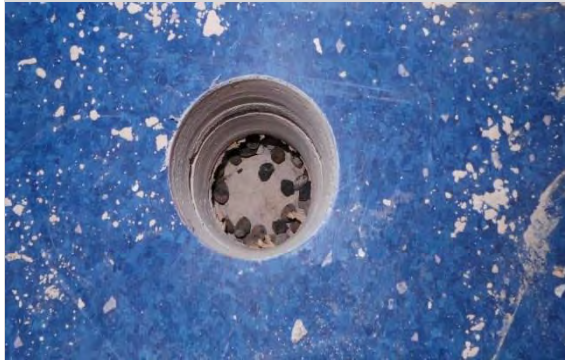
Kuva 47. Vuoden -88 muutoksissa tehty välipohjarakenne.
