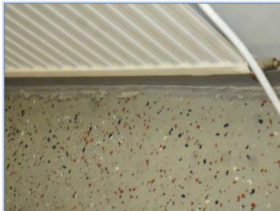
Kuva 15. Lattia/US liittymä tekn. työn tilassa.
