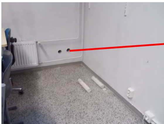
Kuva 5. Luokan 1091 (01) ulkoseinän rakenneavaus.
