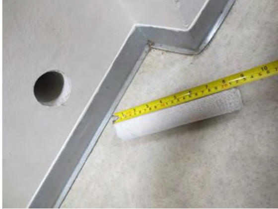
Kuva 17. Luokkatilojen maanvastaisen seinän rakenneavaus.
