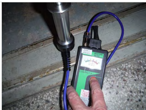
Kuva 10. Portaiden alustilavaraston kosteusvaurioitunut kynnyks.
