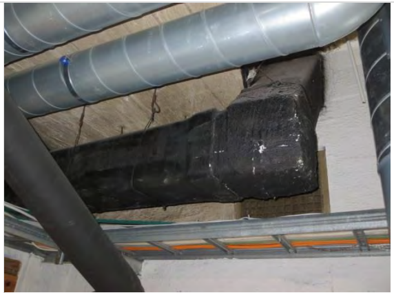
Kuva 68. Vanhoja asbesti-ilmastointiputkia. Tarpeettomat poistettava.
