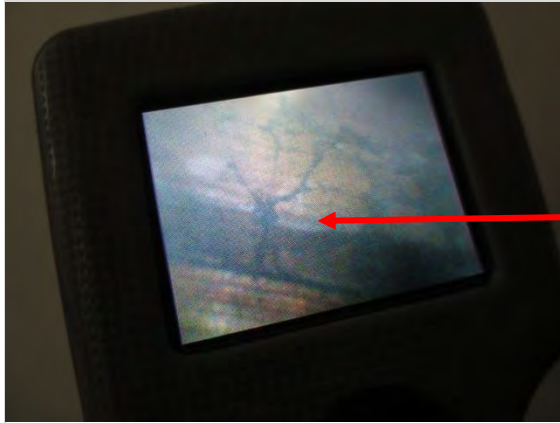
Kuva 31. Halkeamasta näkyvä vesikatteen aluslaudoitus.
