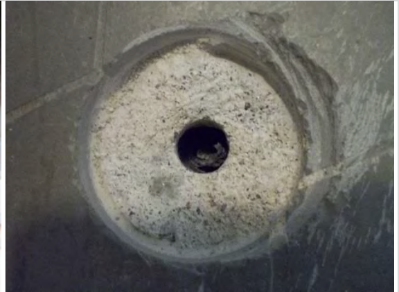
Kuva 50. Asunto-osan luuttujen pesutilan lattian rakeneavaus, jossa näkyvissä bitumivesieristys.
