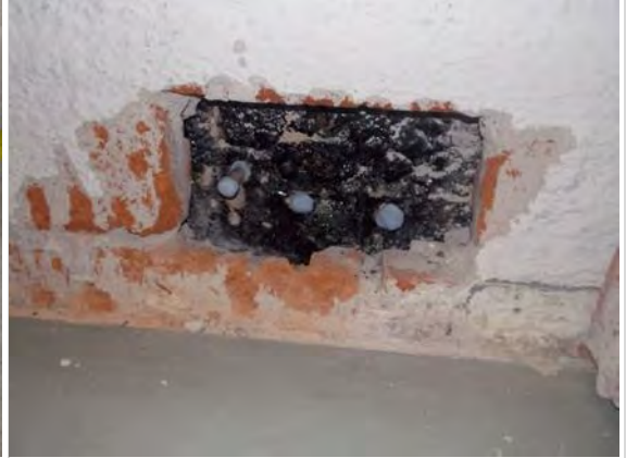
Kuva 18. Kellari käytävän perusmuurin rakenneavaus.
