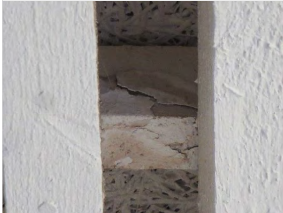
Kuva 35. Kosteusvaurioita alakattorakenteissa.
