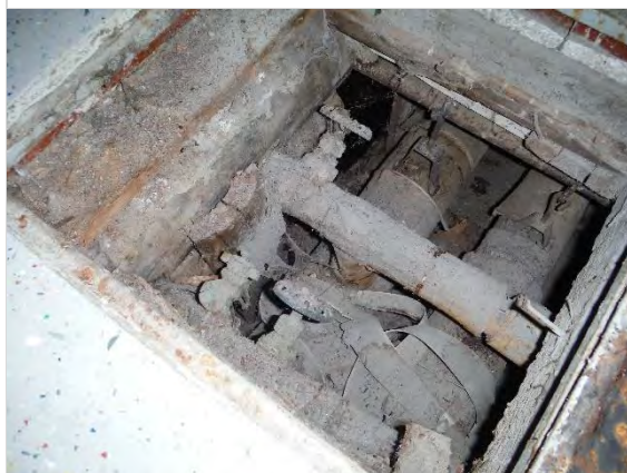
Kuva 13. Näkymä kanaaliin tyttöjen käsityöluokassa olevasta luukusta.
