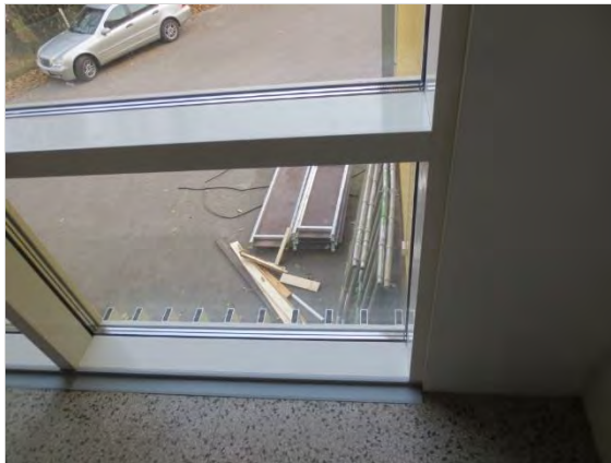
Kuva 53. Ikkunan liittymä seinärakenteeseen ei ole tiivis eikä ikkuna ei ole turvalasia.
