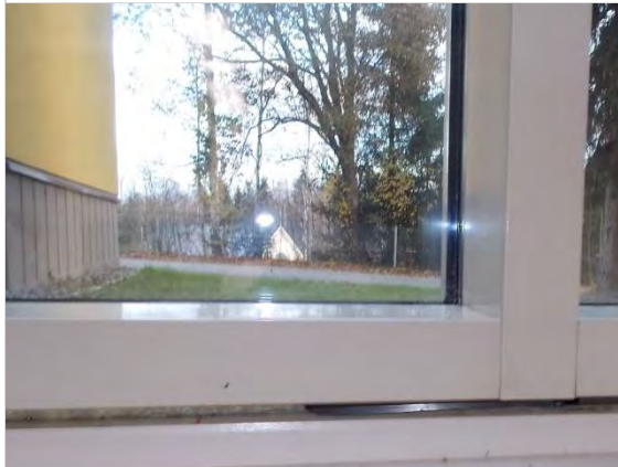
Kuva 53. Ikkunan liittymä seinärakenteeseen ei ole tiivis eikä ikkuna ei ole turvalasia.
