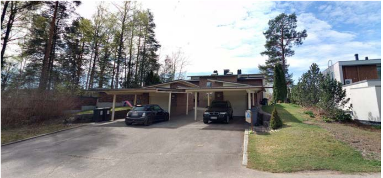
Kuva 22 Huhmarannankatu 9:n paritalo n valmistunut vuonna 2001. Paritalon tiilijulkisivuja on jaoteltu valkoisilla osilla. Tontin rakentamistehokkuus on suunnittelualueen tehokkain.
