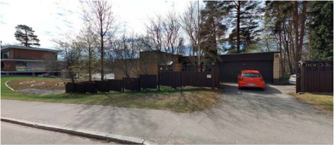
Kuva 20 Keltatiilinen, tasakattoinen Huhmarannankatu 5:n pientalo on valmistunut vuonna 1972.
