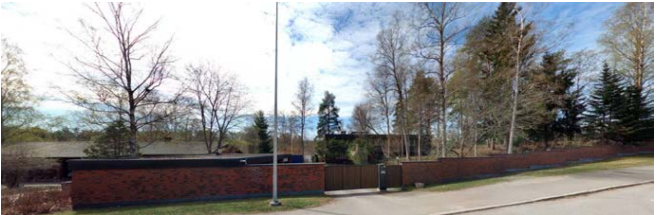
Kuva 23 Huhmarannankatu 13:n tummasävyinen, tasakattoinen asuinrakennus edustaa arkkitehtuuriltaan 1960-luvun tyyliä. Rakennus on valmistunut vuonna 1967.
