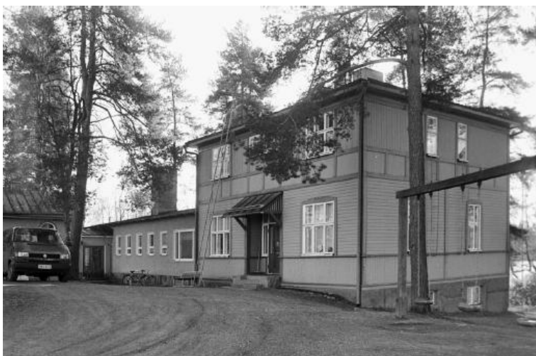
Kuva 14 Alkuperäisen, useaan suuntaan poikkipäädyllisen mansardikaton muuttaminen yksinkertaisemmaksi loivaksi aumakatoksi 1930-1940 luvulla on antanut rakennukselle klassillisen ilmeen (Rakennushistoriaselvitys, FCG 2023).
