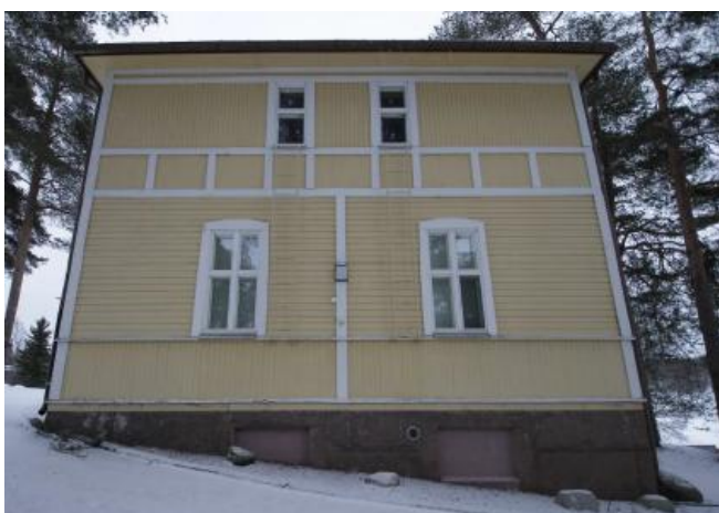
Kuva 15 Huvilaosan aiemmin muuta julkisivua tummemmat nurkkalistat on myöhemmin maalattu valkoisiksi. Kellarikerroksen ikkunoita on myös suljettu ja pienennetty. Rakennuksen itäpäädyssä ollut kuisti ja ulkoporras on poistettu laajennusosan rakentamisen yhteydessä.
