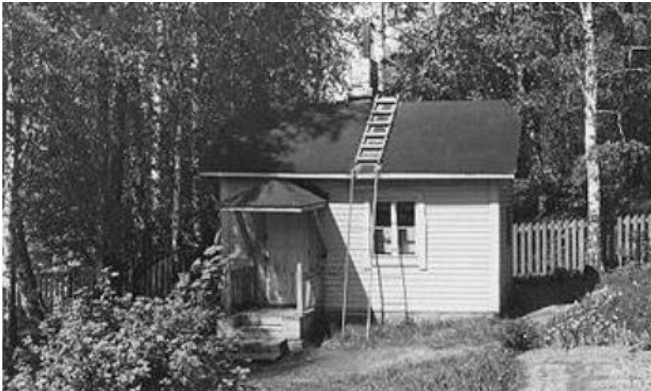
Kuva 17 Rantasauna on osaksi hirttä, osaksi lautarakenteinen.
