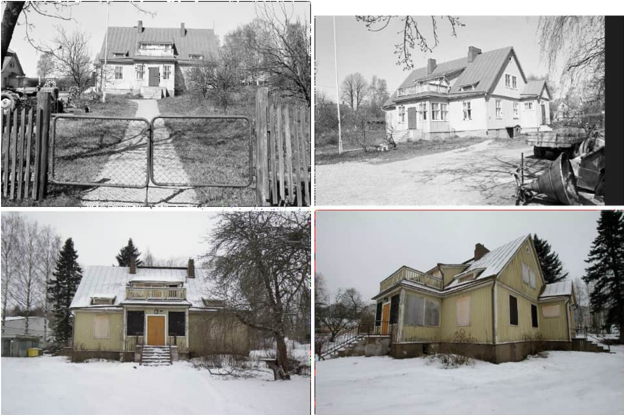
Kuva 10. Ylöstalon tilan asuinrakennuksen julkisivut lounaaseen ja kaakkoon. Mustavalkoiset valokuvat rakennuksesta ovat vuodelta 1974 ja värikuvat 2023. Ikkunat on peitetty, mutta levyjen takana ikkunoissa on edelleen alkuperäiset ulkopuitteet. Julkisivuvuorauksen yksityiskohdat vastaavat 1970-luvun tilannetta. Yksityiskohtien ja tyylin perusteella julkisivuvuoraus ja listoitukset ovat alkuperäiset. (lähde: Kerintie 2:n rakennushistoriallinen selvitys -Ylöstalon tilasta mielenterveystyön toimipisteeksi 2023, FCG).
