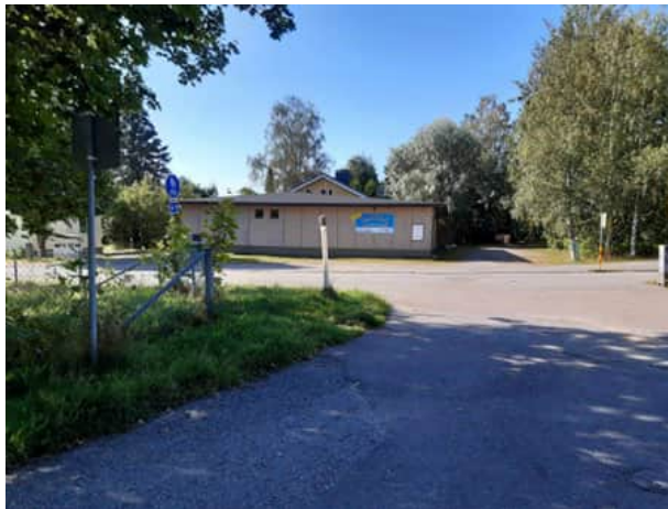
Kuva 7. Suunnittelualueen eteläpuolella, Kerintien varrella, sijaitseva liikerakennus.
