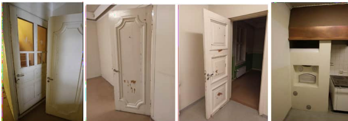
Kuva 12. Rakennuksen sisätilojen peiliovet ja keittiön leivinuuni ovat todennäköisesti alkuperäisiä.
