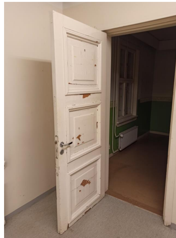
Kuva 98 (oikealla). Keittiön ja ruokailuhuoneen välinen ovi on alkuperäiseltä vaikuttava peiliovi, jossa on kolme peiliä. Pielien rakenne on joko täysranskalainen tai amerikkalainen. Kahva ja lukko on vaihdettu.
