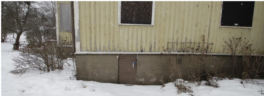
Kuva 60. Kaakkoispäädyssä on kivijalan ryömintätilaan johtava alkuperäiseltä vaikuttava puuovi. Sen vieressä ollut mahdolliseen kellariin johtanut oviaukko on muurattu umpeen. Oviaukon yllä olleen katoksen paikka erottuu julkisivuvuorauksesta. Kuva: FCG, 2023.
