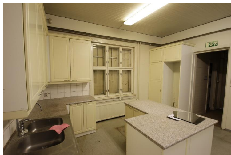
Kuva 110 ja 111 (yllä). Keittiön kalustus on saanut nykyisen hahmonsaa 1980-luvun remontissa, mutta kalusteovet ja tasot vaikuttavat uusitun sen jälkeen. Lattia on harmaata muovimattoa. Sisäseinillä sähkövedot ovat pintavetoja. Katon puupanelointi vaikuttaa alkuperäiseltä. Ulkoseiniä kiertää 1980-luvun remontin aikainen verholauta.
