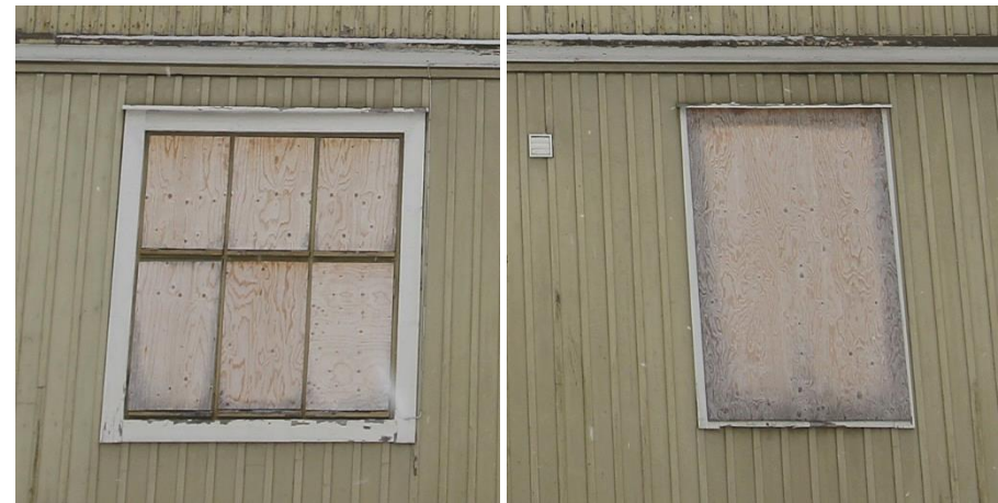
Kuva 66 (yllä). Ullakkokerroksen luoteispäädyn kamarin ikkunat. Otsalaudan keskellä on koriste ja sivuvuorilaudat ovat muotoillut. Palotikkaisiin on kiinnitetty radioantenni.
