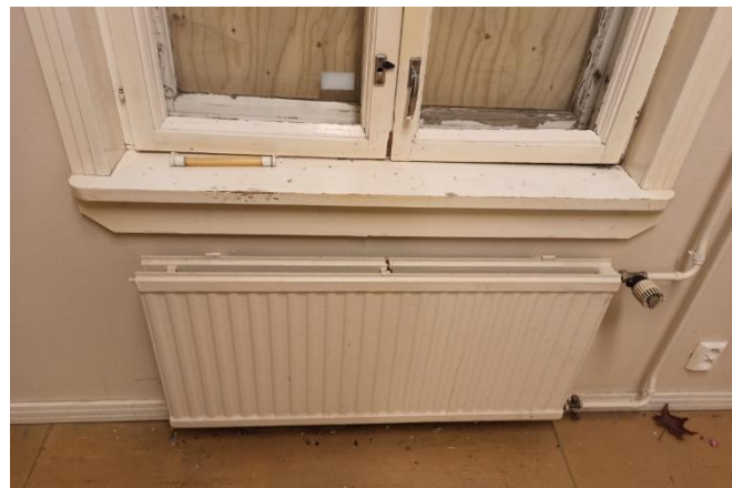
Kuva 101. Lukuhuoneen lattia on ruskeaa muovimattoja 1980-luvulta. Jalkalista samoin kuin ikkunalaute ja ikkunan listoitukset vaikuttavat alkuperäiseltä. Vesikiertoinen patteri on 1980-luvulta. Pistorasiaan tulee sähköveto seinärakenteen sisällä.
