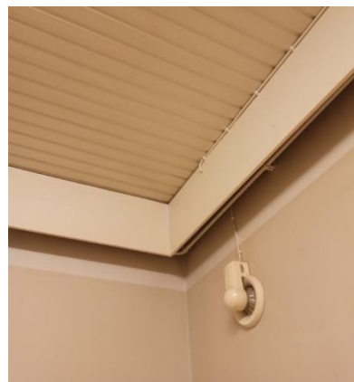
Kuva 102. Lukuhuoneen seinät on maalattu beesinsävyisiksi. Ulkoseinillä kiertää verholautaa. Katon puupanelointi vaikuttaa alkuperäiseltä. Ilmanvaihtoa on tehostettu koneellisesti ulkoseinässä olevassa venttiilissä.
