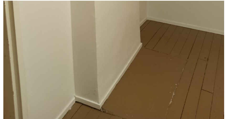
Kuva 137 (vasemmalla yllä). Näkymä luoteispäädyn kamariin ovelta. Huoneessa vaikuttaa olevan alkuperäinen laualattia, joka on maalattu ruskeaksi. Katon verhoilu on 1980-luvulta puukuitulevyä.
