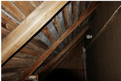
Kuva 42 (yllä). Kattorakenne kylmässä ullakkotilassa rakennuksen sivulla. Vesikatetta kannattaa tuppeensahatut laudat, joita on paikoin melko harvassa.
