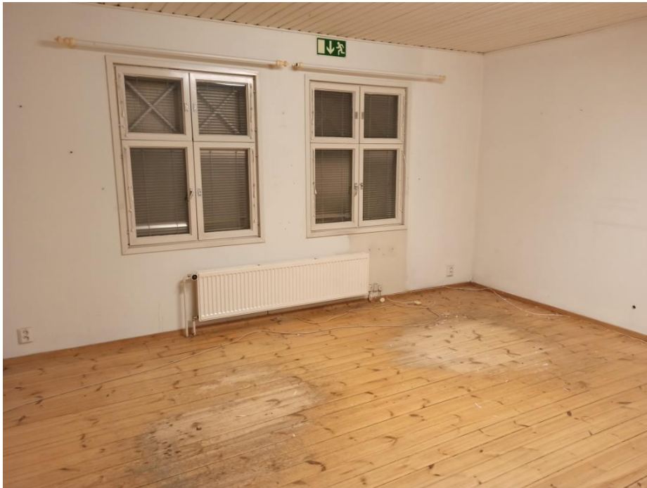
Kuva 140 (vasemmalla yllä). Kaakkoispäädyn pintamateriaalit vaikuttavat 1980-luvulla uusituilta. Katon panelointi on tasalaatuisempi kuin alakerran huoneissa oleva panelointi. Lattia on lakattua mäntylautaa. Ikkunoiden ääressä on ilmeisesti ollut työpaisteet ja työtuolit ovat kuluttaneet lattiaan jäljet.
