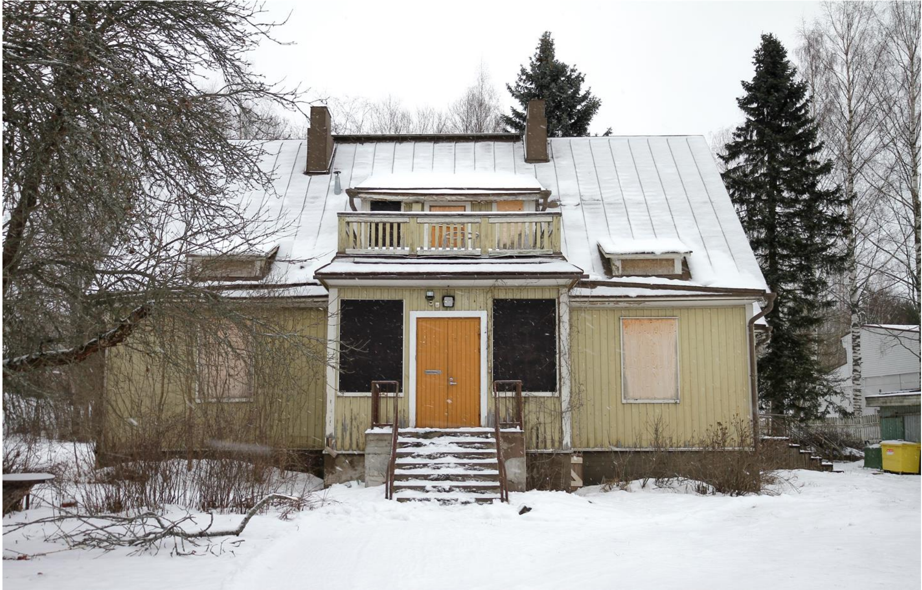
Kuva 1. Kerintie 2:n pääjulkisivu lounaaseen.
