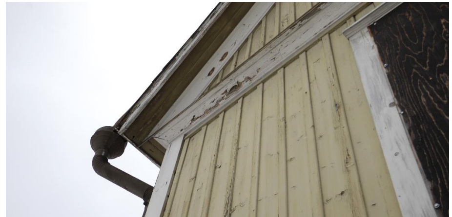
Kuva 32 (yllä). Kattokulma on melko jyrkkä ja päätykolmiota korostaa vaakalista. Ullakkokerroksessa päätyikkunoiden vuorilaudat ovat muotoillut ja ikkunoiden otsalaudassa on koriste. Harjan pienen ikkunan vuorilaudat muodostavat ympyrän.
