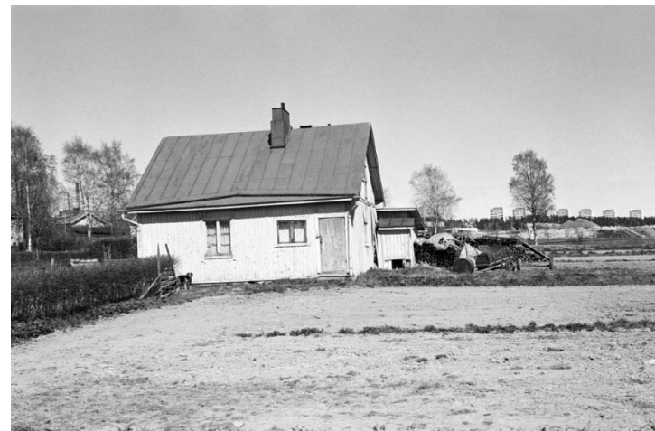
Kuva 26. Ylöstalon pihapiirin reunalla ollut pieni asuinrakennus 1974. Ilmakuvien perusteella se on purettu vuosien 1979 ja 1986 välillä. Ylöstalon peltoaukea on vielä avoin. Taustalla näkyy Ruolan korkeat kerrostalot. Yrjö Puuperä. Kuvälähde: Lahden museot, kuvakokoelmat.
