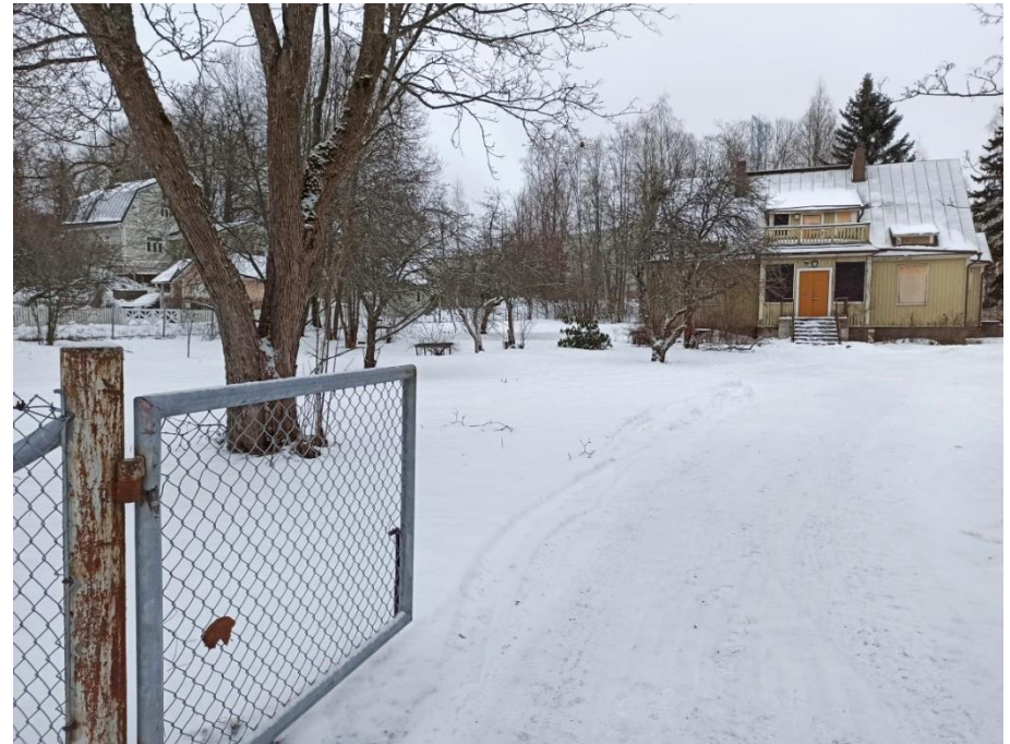
Kuva 74. Näkymä Kerintieltä pihatietä pitkin kohteen päärakennukselle. Kohteen piha on aidattu katujen varsilta verkkoaidalla. Metallikehyksisessä portissa on käytetty samaa verkkoa. 1970-luvun valokuvissa pihaa rajaa lauta-aita ja portti on nykyistä kapeampi ja sirompi metalliverkkoportti. Kuva: FCG, 2023.
