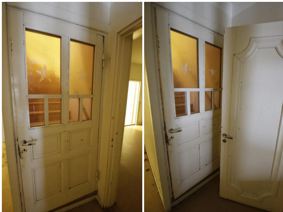
Kuva 99 (vasemmalla). Yläkerran portaiden ovi eteisaulaan on ikkunallinen peiliovi. Se on jaettu pystysuunnassa kolmeen ja vaakasuunnassa kahteen osaan. Ylimmät peilit ovat lasia, alemmat puuta. Lisäksi ylimmät peilit ovat korkeimmat ja keskimmäiset matalimmat. Kehyksen ja peilien välissä on profiloimaton lista. Ovi vaikuttaa alkuperäiseltä.
