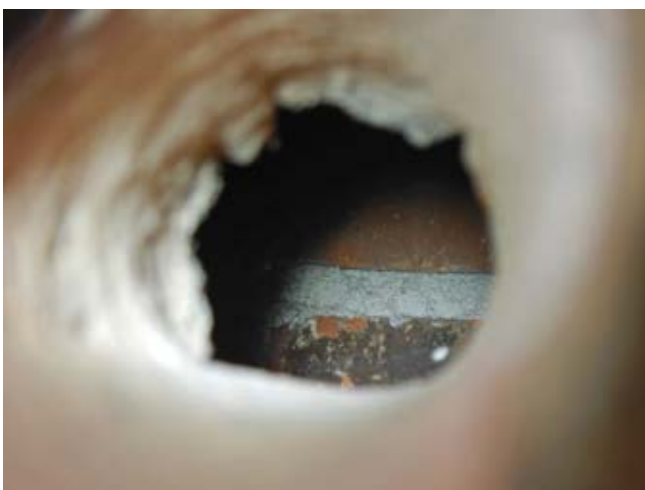
Kuva 27. B- ja C-osien välinen seinä kellarikerroksessa RA6
