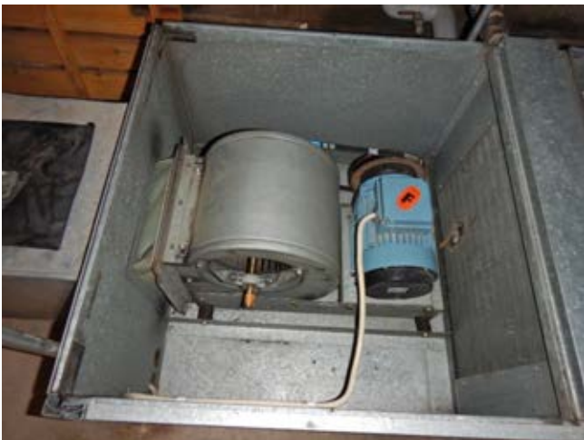
Kuva 60. Yleiskuva TK-1 puhallinkammioista. Kammio oli puhdas
