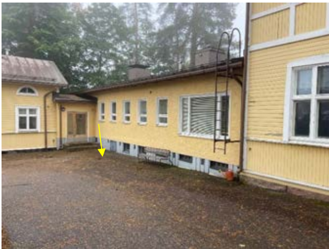
Kuva 1. Etupihan puolella on asfaltointia, pihalla on nurkassa salaojakaivo (nuoli). Sadevedet on viemäroity.
