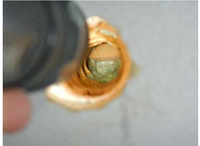
Kuva 16. Ulkoseinän lämmöneristeenä on mineraalivillaa
