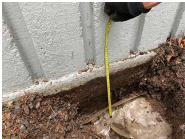
Kuva 4. Takapihalla koekuopassa vanha perusmuurin vedeneristekermi ja vaakasuuntainen rakennusmuovi.
