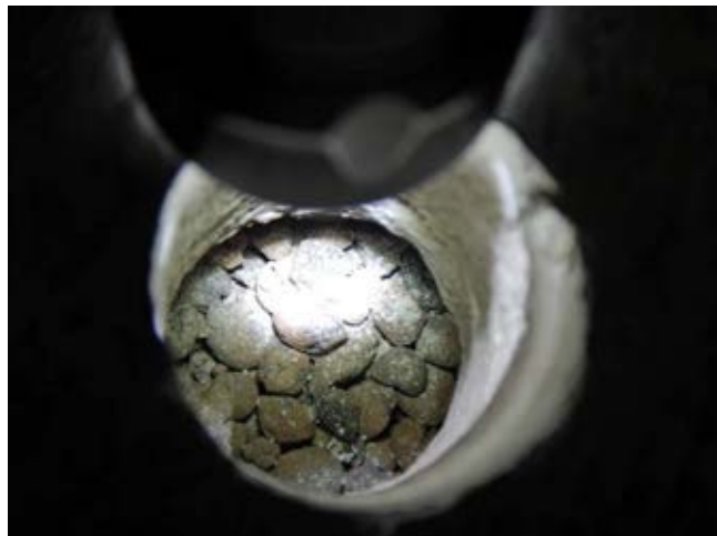
Kuva 10. Alapohjan kevytsoraeristettä rakenneavauskohdassa RA3
