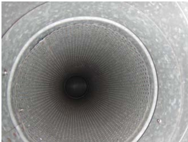
Kuva 87. Vanha äänenvaimennin B010 kohdalla.
