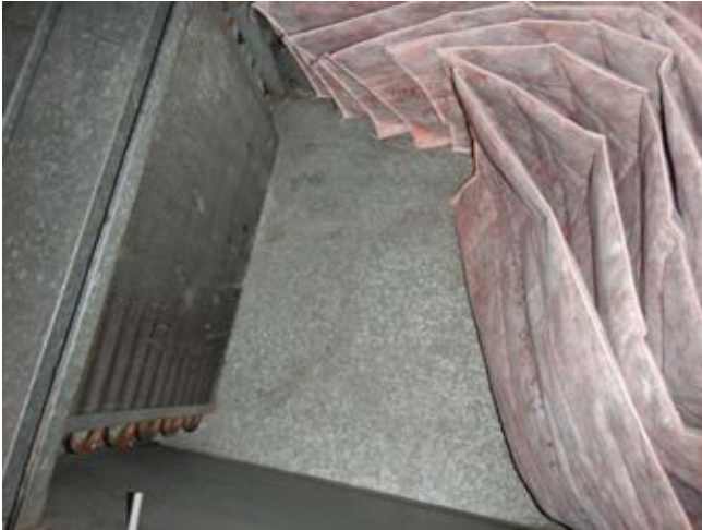
Kuva 58. TK-1 suodatinkammio oli puhdas
