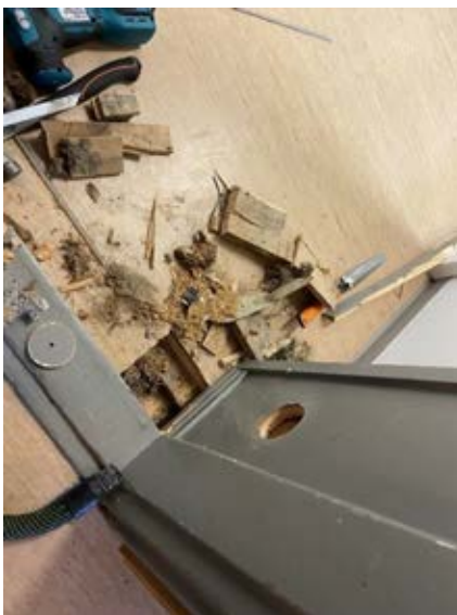
Kuva 28. B- ja C-osien väliseinä rakennetta tarkasteltiin välipohjaan tehdyn avauksen sekä ovipieleen tehdyn avauksen kautta
