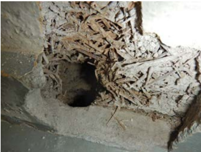
Kuva 13. Maanvastaisen ulkoseinän rakenneavauskohta RA4
