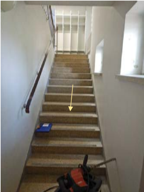
Kuva 37. Portaan alunen tarkastettiin porrasaskelmaan tehdyn avauksen kautta RA8
