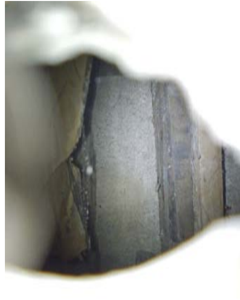
Kuva 38. Portaan alla on vanhaa puista muottirakennetta
