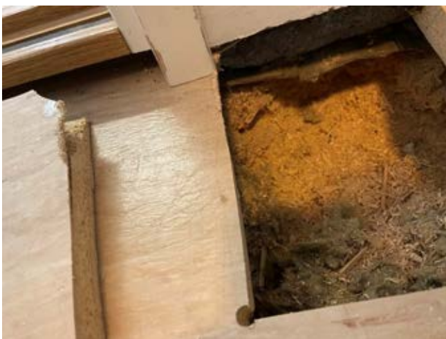
Kuva 23. Rakenneavaus A-B osien liitoskohdan välipohjarenteen RA38
