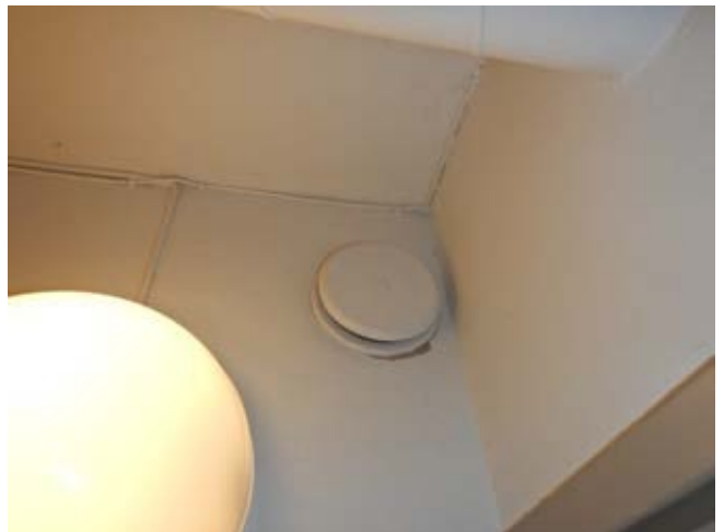
Kuva 49. Poistoilmaventtiili yleisesti
