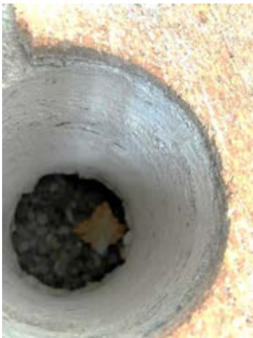
Kuva 9. Alapohjarakenne rakenneavauskohdassa RA20
