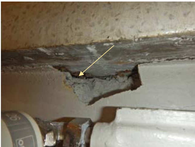
Kuva 19. Ikkunapenkin alapinnassa on valupaperikaistale. Kuva tilasta B005
