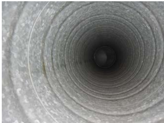
Kuva 83. TK-2 1. kerroksen käytävän runkokanava. Kanava silmämääräisesti puhdas
