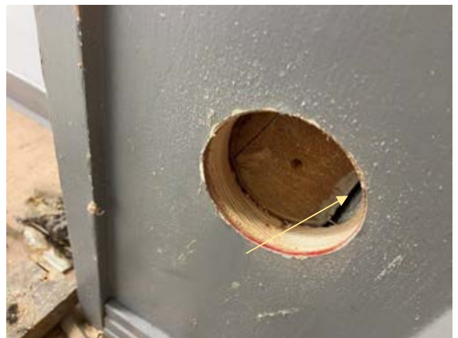
Kuva 29. C-osan vanha hirsirunkoinen väliseinä on kiinni B-osan tiilimuurauksessa
