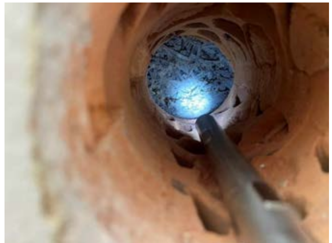
Kuva 18. Sokkelissa on ulkokuoren sisäpinnassa lastuvillasementtieriste
