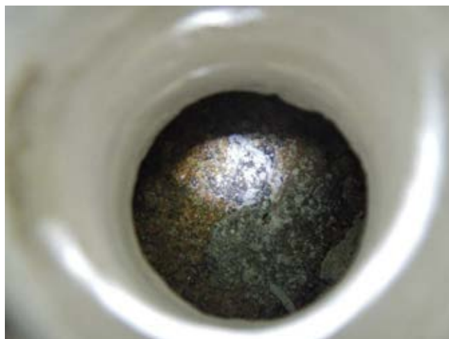
Kuva 12. Alapohjan maatayttonä on kosteaa, hienojakoista hiekkaa
