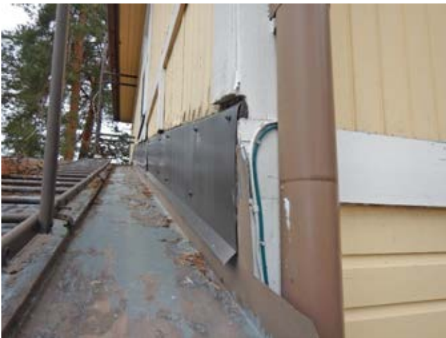
Kuva 33. Vesikatteen ylösnosto rakennusosien liitoskohdassa
