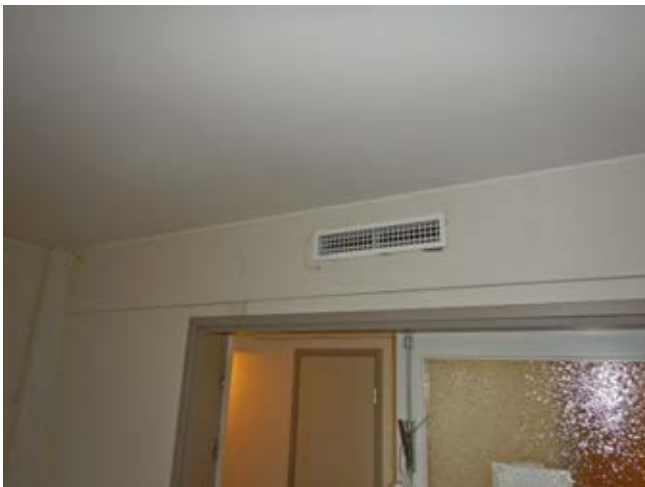
Kuva 52. 0. krs takahuoneen tuloilmaventtiili
