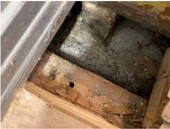
Kuva 25. Välipohjan rakenneavaus B- ja C-osien liitokseen RA28
