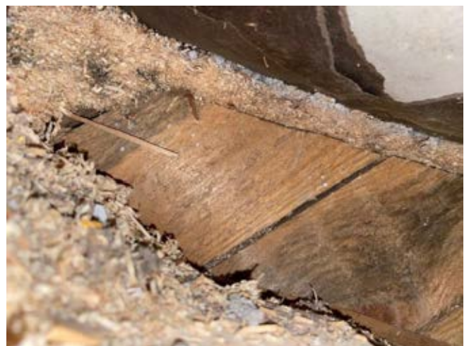
Kuva 24. A-osan puolella, B-osan vastaista betonivälipohjaa/ulkoseinää vasten tervapaperi. Kuvan vinolaudoitus on A-osan alapohjan alapinnan laudoitusta
