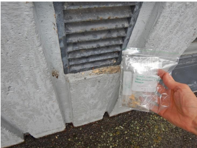
Kuva 9. ASB.08 Sokkelin harmaa maali ei sisällä asbestia
