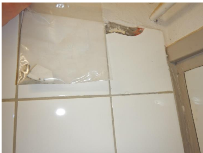
Kuva 5. ASB.04 Pesutuvan 012, valkoinen 150*150 mm seinälaatta + kiinnityslaasti + saumalaasti ei sisällä asbestia
