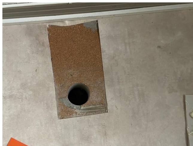
Kuva 14. ASB.13 Kellarin majoitushuoneen B003, lattian korkkipäällyste + kiinnitysliima + lattiatasoite ei sisällä asbestia
