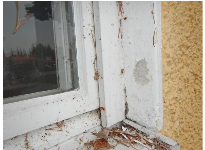
Kuva 8. ASB.07 Ikkunasmyygin valkoinen maali + rappaus ei sisällä asbestia
