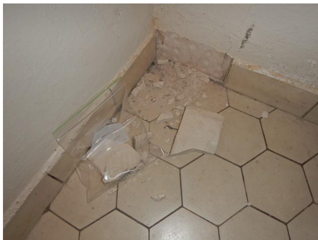
Kuva 4. ASB.03 Likapyykkitalan B019, lattian 6-kulmainen lattialaatta + kiinnityslaasti + saumalaasti ei sisällä asbestia
