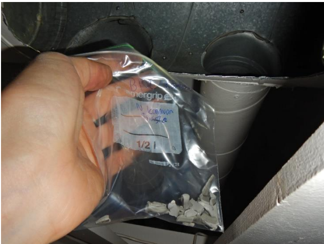
Kuva 17. ASB.16 Käytävän B102, ilmanvaihtokanavan harmaa tiivistysmassa ei sisällä asbestia
