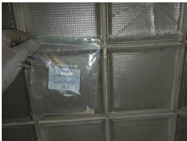
Kuva 6. ASB.05 Porrashuoneen B007, lasitiiliseinän saumalaasti ei sisällä asbestia
