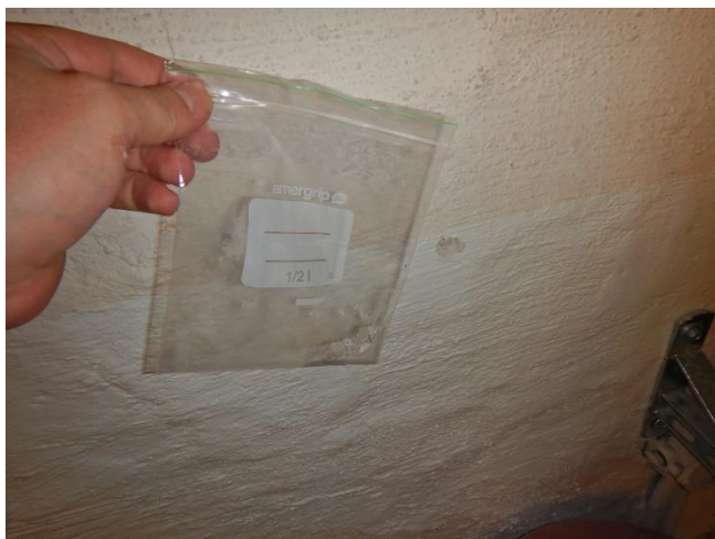
Kuva 3. ASB.01 Kellarin lämmönjakohuoneen B009, seinärappaus ei sisällä asbestia
