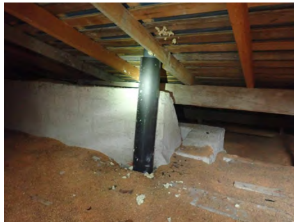
109. Tuuletusviemäri eristetty.
