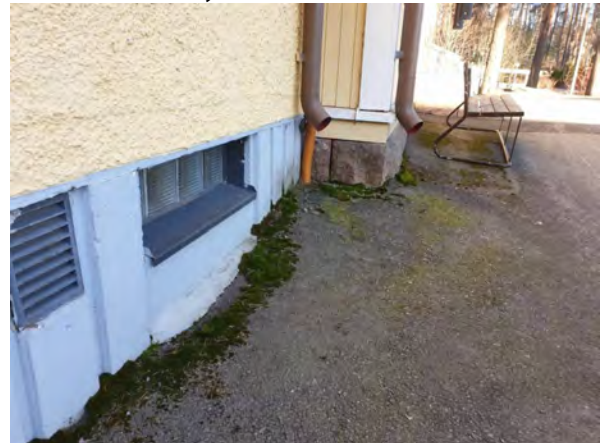
26. Perustukset ja sokkelit
