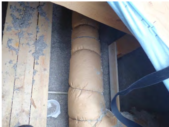
108. Tuuletusviemäri eristetty.
