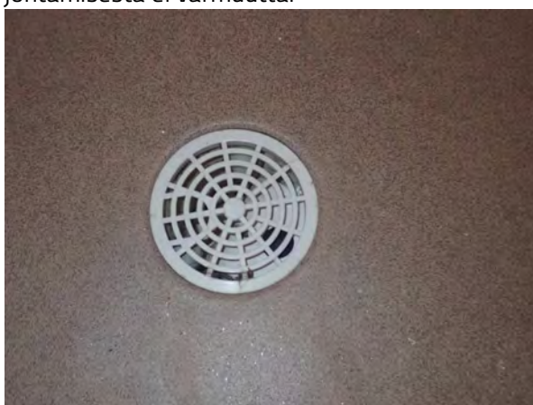
103. Lattiakaivo oletettavasti vuodelta 1988.
