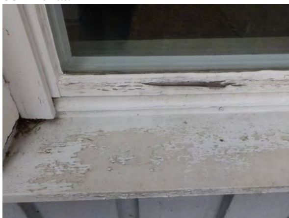
35. Ikkunaa ja ikkunapeltiä.
