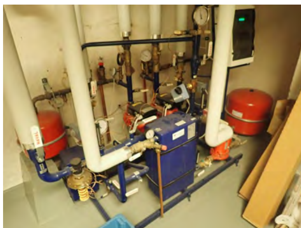
68. Lämmönsiirrinpaketti.
