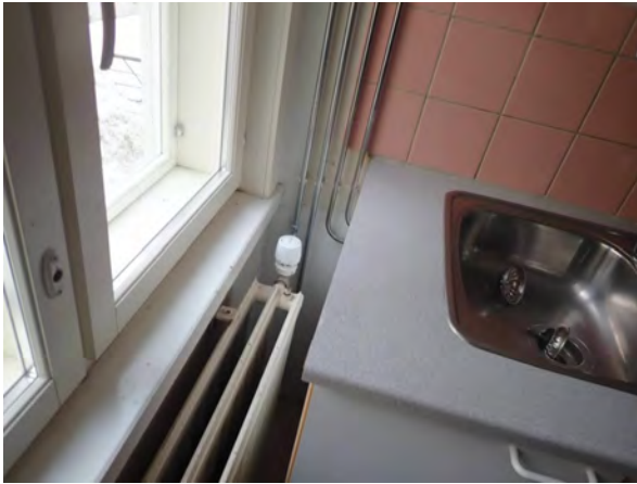
76. Lämpöjohtoja uusittu.
