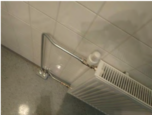
81. Termostaattinen patteriventtiili sekä patteri uusi.
