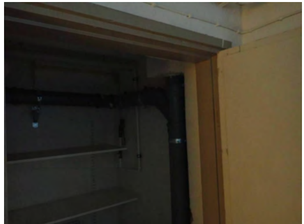
100. Viemärit ovat muovia.
