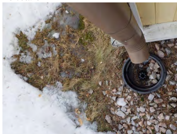
4. Sadevesikaivo on asennettu.
