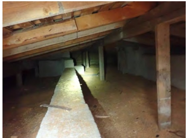
48. Yläpohjatilaa, eristeenä purua
