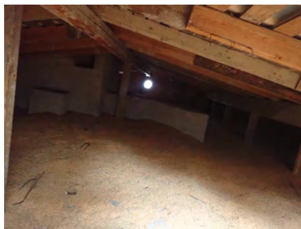
50. Yläpohjatilan tuuletus aukko näkyy peräseinällä.
