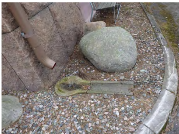
3. Betonikourua sadeveden ohjaukseen pois rakennuksen vierustalta.
