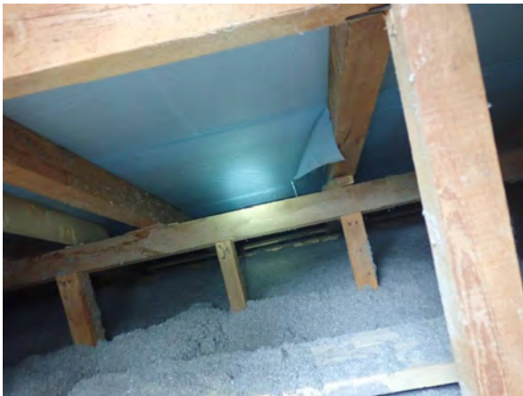
47. Yläpohjatilaa, aluskate on asennettu
