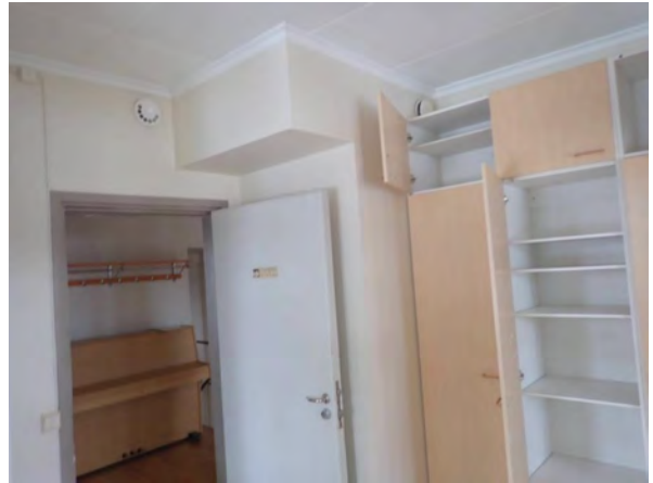
128. Poistoventtiilinä lautasventtiili koneellisen ilmanvaihdon alueella.
