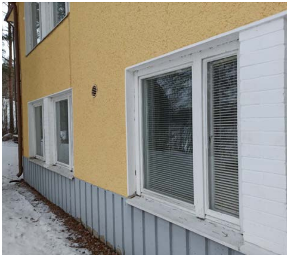
Kuva 100. Lounaisjulkisivun parittaiset, neliömäiset tuuletusikkunalliset ikkunat. Ikkunaparien väli on valkoiseksi maalattua, puhtaaksi muurattua tiiltä. Ikkunat ovat alkuperäiset 1950-luvun ikkunat.
