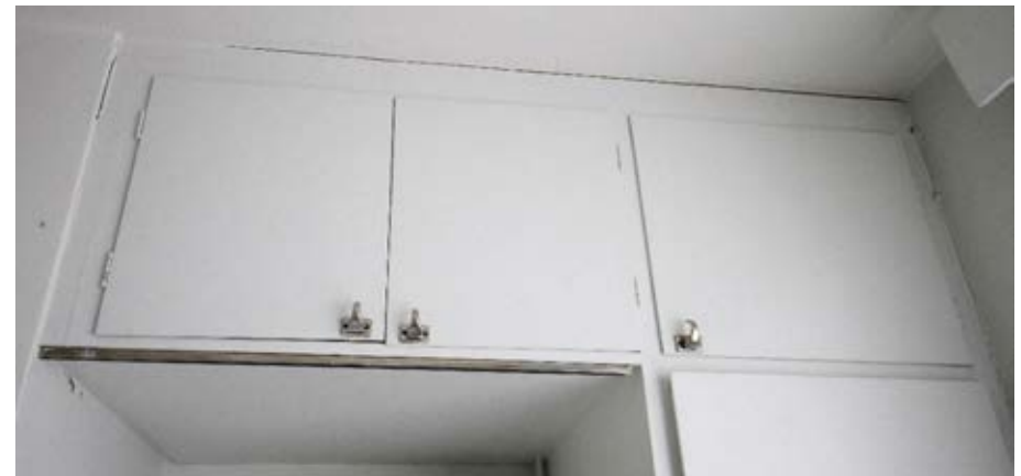
Kuvat 153 ja 154: Henkilökunnan huoneista löytyy alkuperäisiä 1950-luvun kiintokalusteita. Kuvat: FCG, 2023.
