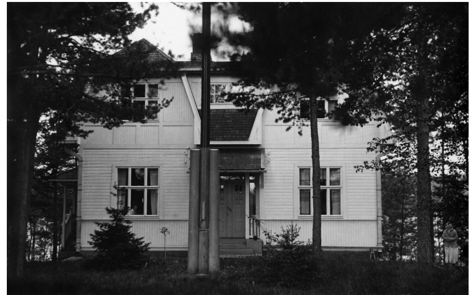
Kuva 30: Huhmarannan lastenkodin päärakennus. Rakennuksen pääjulkisivu on symmetrisesti sommiteltu ja sitä hallitsivat kookkaat taitekattoiset poikkipäädyt. Peilipari-ovet, suuret ruudutetut ikkunat ja vaaka- ja pystypaneloinnin vaihtelu kiinnittävät myös huomion. Itäpäädyssä on pieni avokuisti, joka purettiin viimeistään lisärakennuksen rakentamisaikana. Kuva on ajoitettu Lahden museoissa 1930-luvulle. Kuva on kuitenkin todennäköisesti vuodelta 1927. Tältä vuodelta rakennuksesta on runsaasti muitakin kuvia. Kuva: Lahden museot, kuvakokoelmat.
