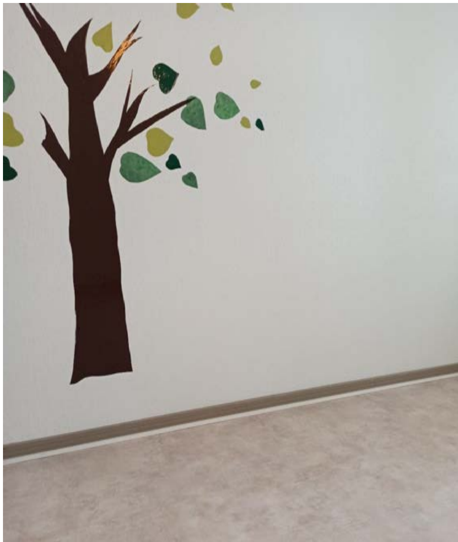
Kuvat 169, 170 ja 171 : Ensimmäisen kerroksen kolmen lastenhuoneen, entisen eristys-huoneen ja kanslian lattiat on päällystetty muovimatolla todennäköisesti 2010-luvulla. Seinissä on lasikuitutapetti. Huoneiden ikkunat ovat alkuperäiset. Kuvat: FCG, 2023.
