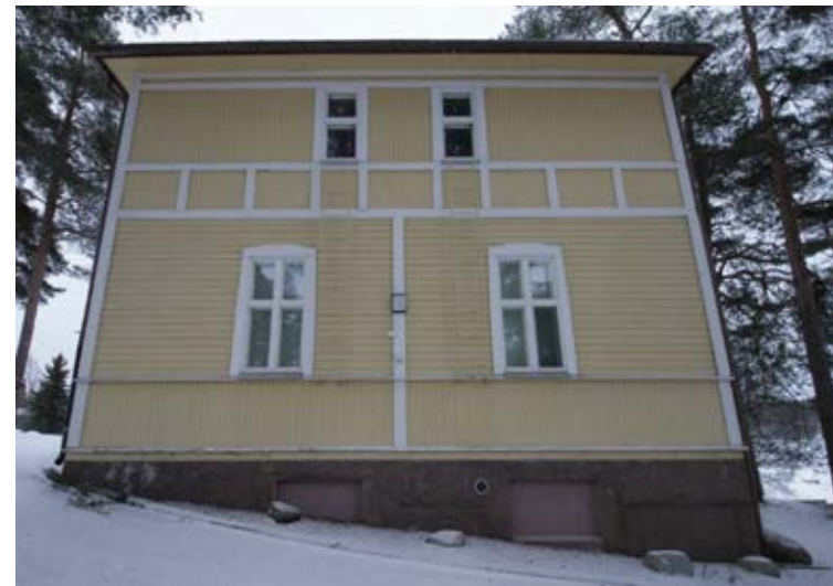
Kuva 67 (yllä). Päärakennuksen koillisjulkisivu on jäsentelyltään symmetrinen.
