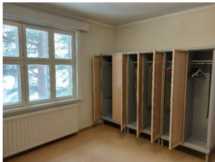
Kuva 132: Entisessä henkilökunnan huoneessa on muovimatto ja kipsilevykatto. Kuva: FCG, 2023.
