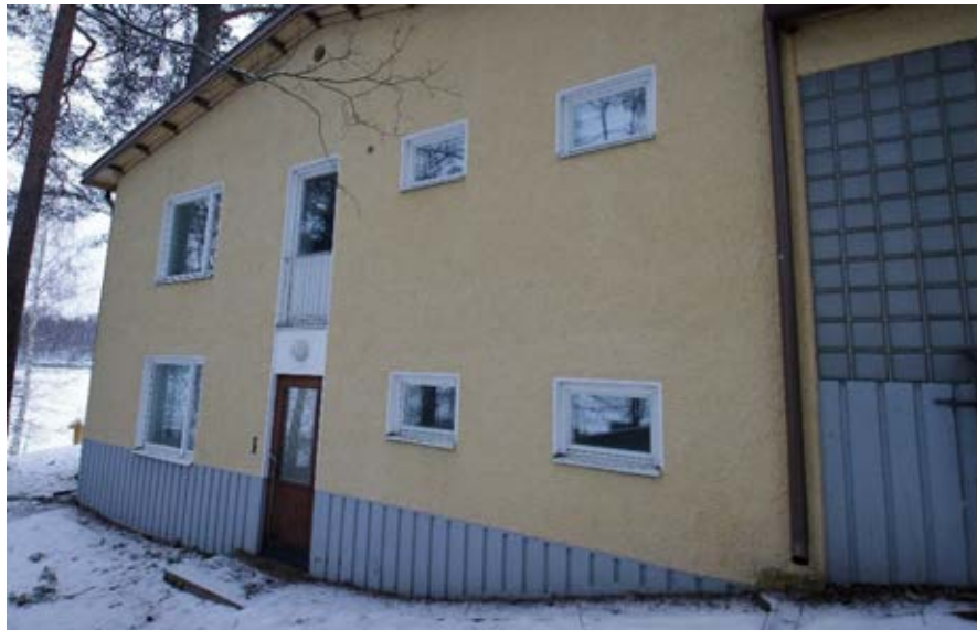
Kuva 46: Laajennusosan lyhyessä päädyssä on vaatimattomampi maalattu ulko-ovi. Suuri lasitiili-ikkuna erottuu kuvan oikeassa reunassa. Kuva: FCG, 2023.
