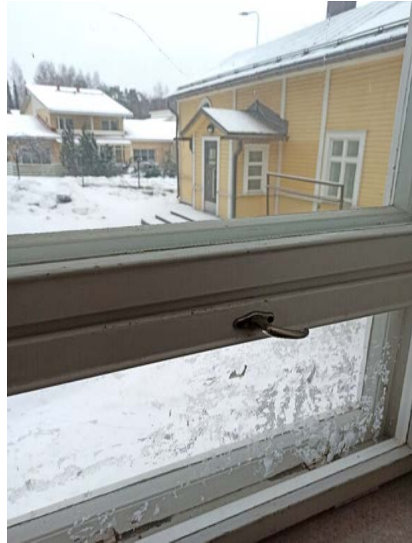
Kuvat 164 ja 165: Vasemmalla: Laajennusosan ensimmäisessä kerroksessa on jäljellä alkuperäisiä 1950-luvun ovia heloineen. Yllä: Kaikki rakennuksen ensimmäisen kerroksen ikkunat heloineen ovat alkuperäiset. Kuvat: FCG, 2023.
