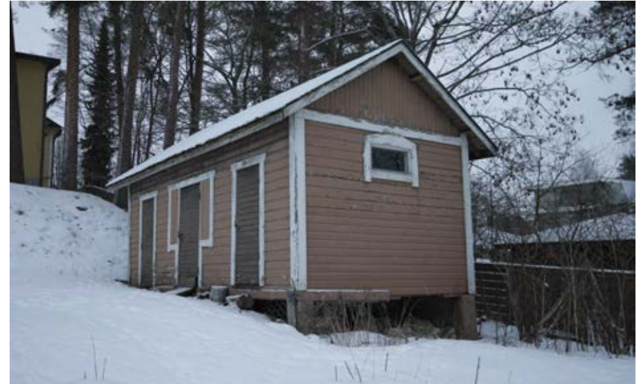
Kuva 56: Vanha varasto ja ulkokäymälä on rakennettu graniittipaasien varaan. Ikkunan viistetyt vuorilaudat ovat samaa tyyliä kuin päärakennuksessa. Toisella puolen varastoa lyhyen päädyn ikkuna on laudoitettu umpeen, vain vuorilaudat ovat jäljellä. Kuva: FCG, 2023.
