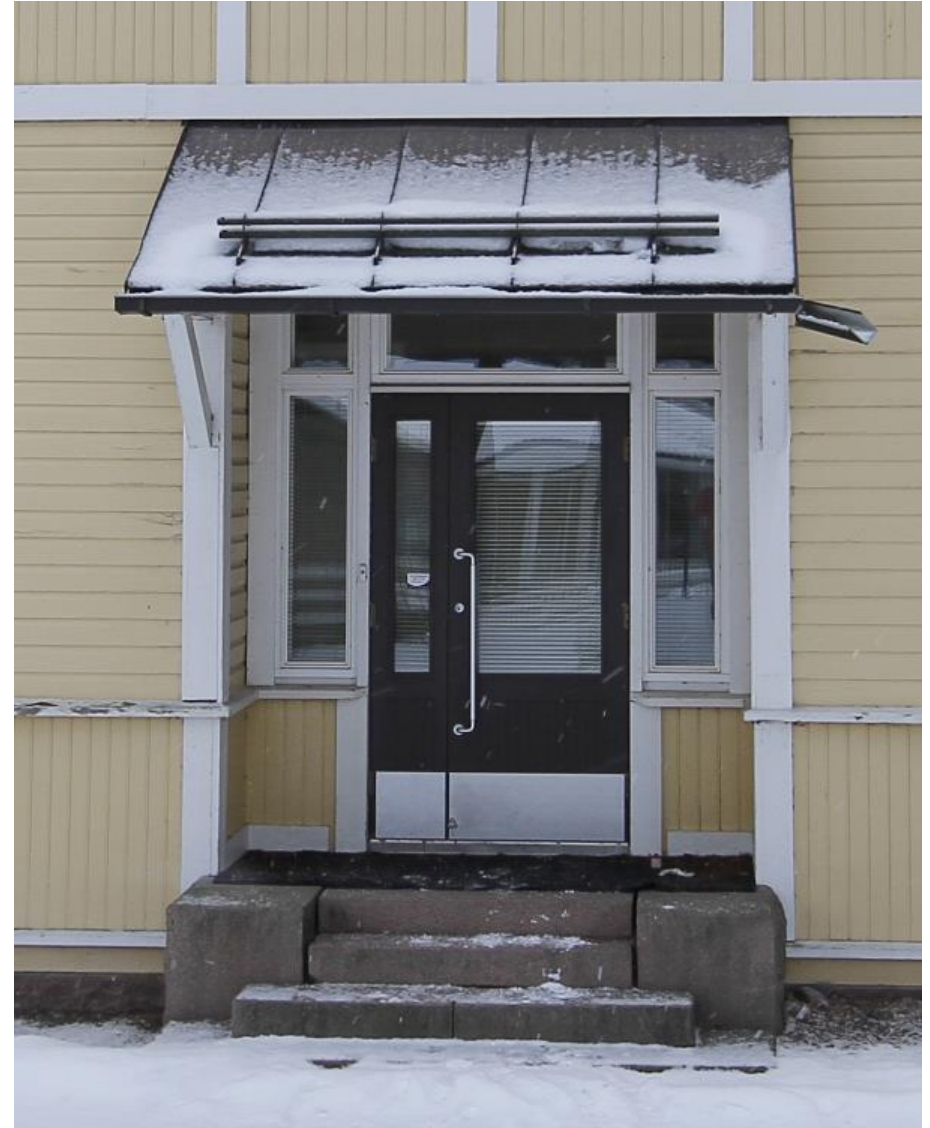
Kuva 82. Päärakennuksen pääsisäänkäynti sijaitsee pienessä syvennyksessä. Portaat ovat luonnonkivistä ja alkuperäiset. Ikkunat ja ovi on uusittu.
