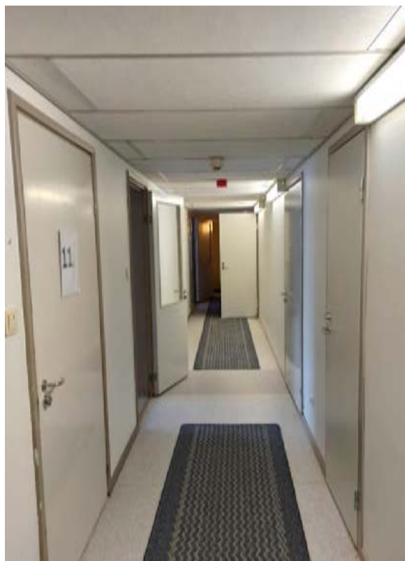
Kuvat 39, 40 ja 41: Vasemmalla: Kellarissa on moduulimittaisista levyistä koottu ripustettu alakatto. Alakaton asentamisen vuoksi kellarin huonekorkeus on madaltunut alkuperäisen leikkauspiirustuksen osoittamasta 2400 millistä, sillä oven karmin ja alakaton väliin jää vain noin 100 mm tilaa. Kuva: FCG, 2023.
