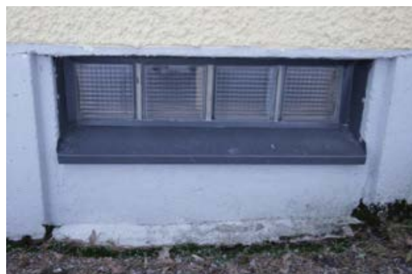
Kuva 101 (yllä). Koillisjulkisivun pienemmät pystyikkunat ovat myös alkuperäisiä 1950-luvun ikkunoita.
