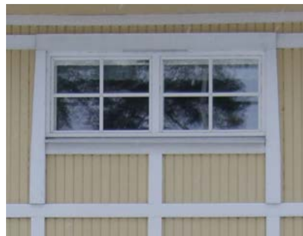
Kuva 93. Päärakennuksen koillisjulkisivulla on yläkerroksessa myös matala pari-ik-kuna, jonka ruudut on jaettu koristelistoilla neljään osaan.
