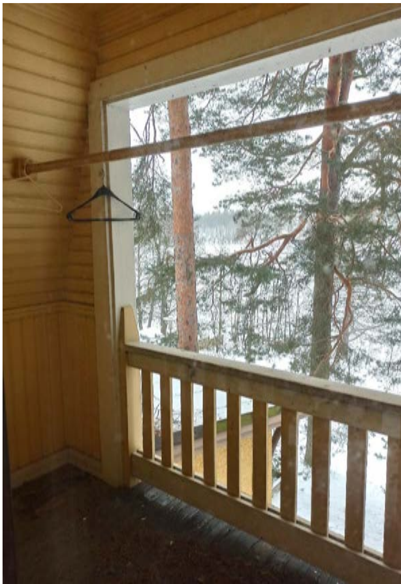
Kuva 130: Parvekkeen kaiteen viistetty pää on muotokieleltään samanlainen kuin huvilan ikkunoiden viistetyt vuorilaudat. Kuva: FCG, 2023.
