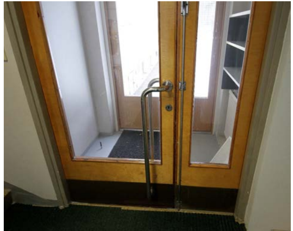
Kuva 47: Laajennusosan koivuviilupintainen pääovi on alkuperäinen ja tyyliiltään tyypillistä 1950-lukua. Kuva: FCG, 2023.
