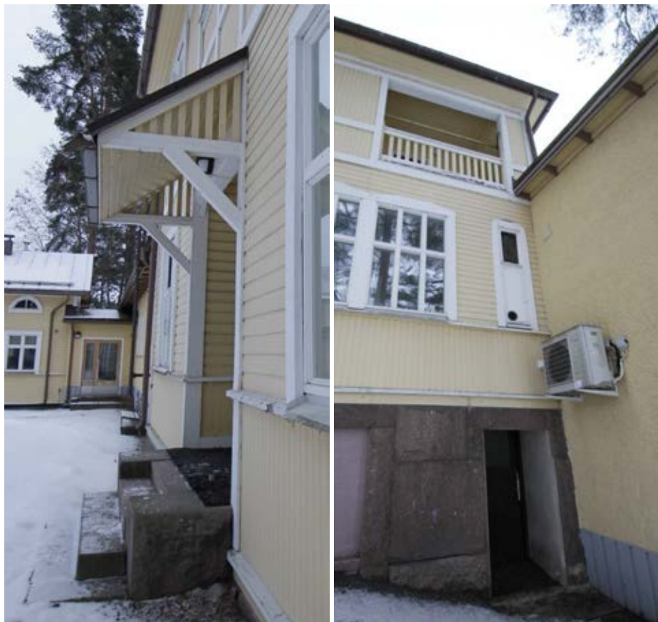
Kuva 83 (vasemmalla). Päärakennuksen pääsisäänkäynti kuvattuna sivulta. Lapekat-toisen katoksen päädyissä on harva laudoitus. Katos on tuettu seinärakenteisiin. Van-hojen valokuvien perusteella katos on ollut lisäksi tuettu kahdella pilarilla.
