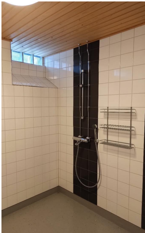
Kuvat 156, 157, 158 ja 159: Sauna ja pesuhuone ovat kauttaaltaan uusitut. Alkuperäisten lasitiili-ikkunoiden yläreuna on jäänyt hieman piiloon pesuhuoneen sisäkaton uusimisen myötä. Kuvat: FCG, 2023.
