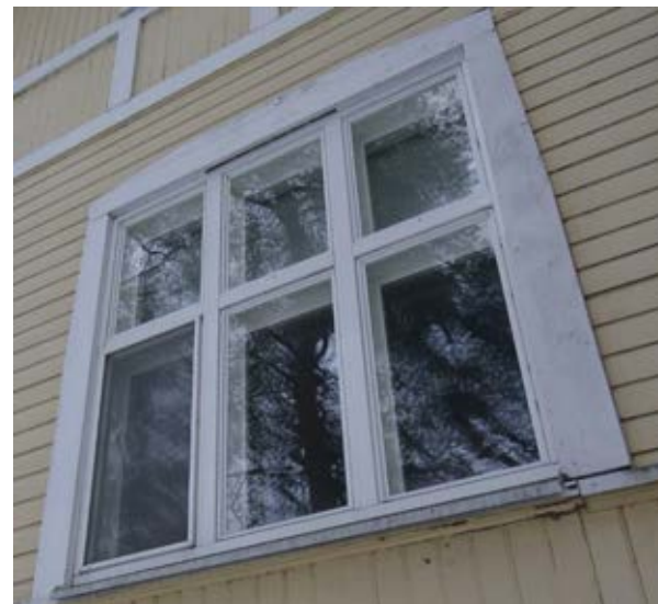
Kuva 92. Päärakennuksen lounaisjulkisivun ikkuna. Ilmanvaihtoaukko näkyy yläkar-missa. Tuuletusikkunan ulkopinnassa on hyönteisverkko.
