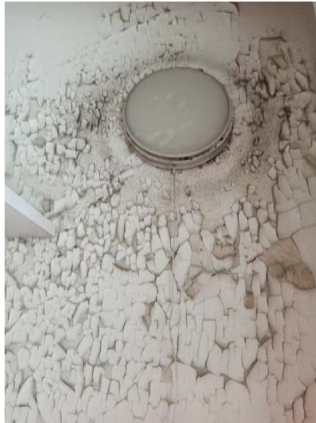
Kuvat 160, 161 ja 162: Seinien maalipinta on kärsinyt eniten entisessä silityshuoneessa varsinkin ilmanvaihtokanavan ja ikkunan ympäristössä, mikä viittaa mahdolliseen kosteusvaurioon. Kuvat: FCG, 2023.
