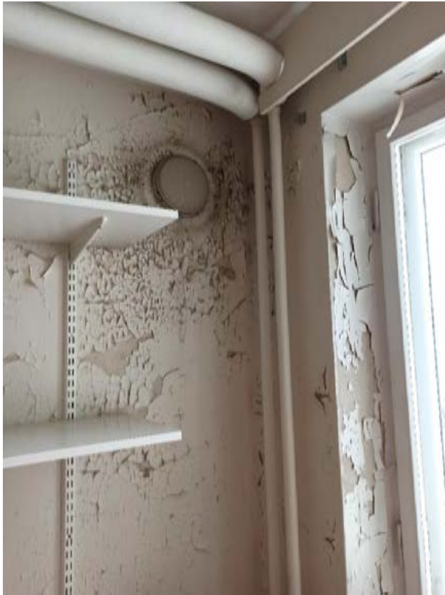
Kuvat 160, 161 ja 162: Seinien maalipinta on kärsinyt eniten entisessä silityshuoneessa varsinkin ilmanvaihtokanavan ja ikkunan ympäristössä, mikä viittaa mahdolliseen kosteusvaurioon. Kuvat: FCG, 2023.
