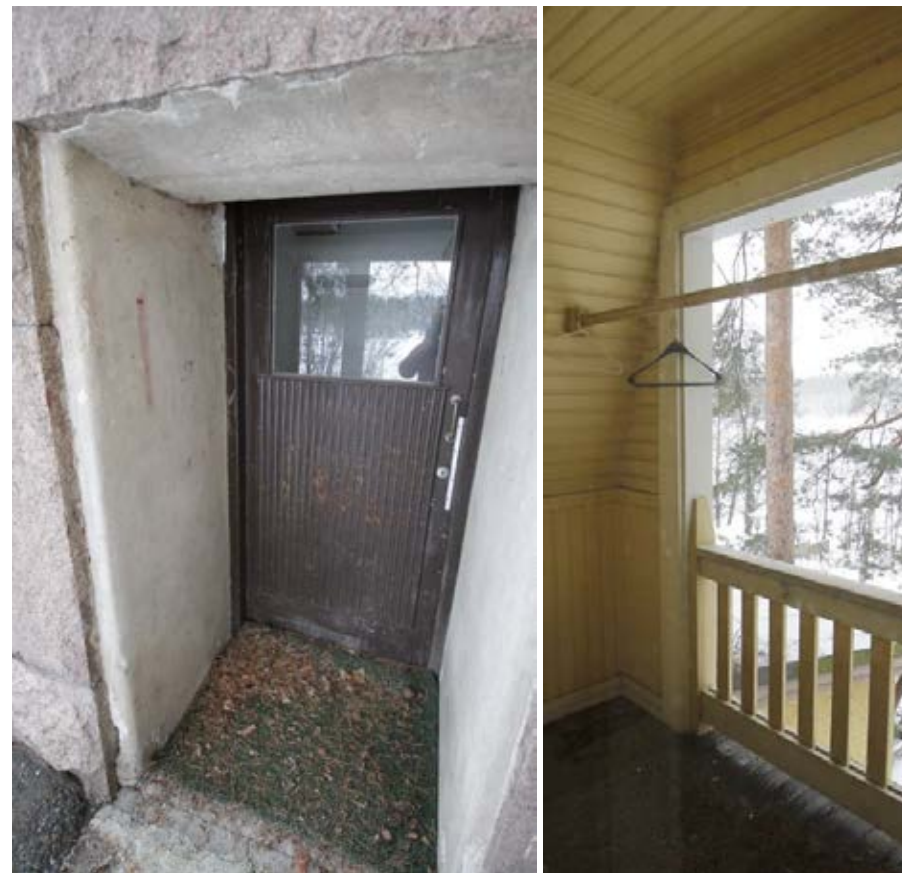
Kuva 85. Päärakennuksen kellarin ulko-ovi vaikuttaa ennemmin 1950-luvun puupa-neloidulta ovelta kuin alkuperäiseltä 1920-luvun ovelta.
