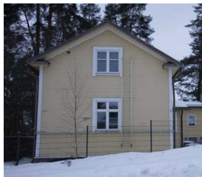
Kuva 72 (yllä). Asuinrakennuksen luoteisjulkisivu. Hirsirakennuksen väliseinien paikat hahmottuvat julkisivussa. Kuvassa oikeanpuolimmaisena näkyvä osa saattaa olla betonisten nurkkakivien perusteella myöhemmin tehty laajennus.
