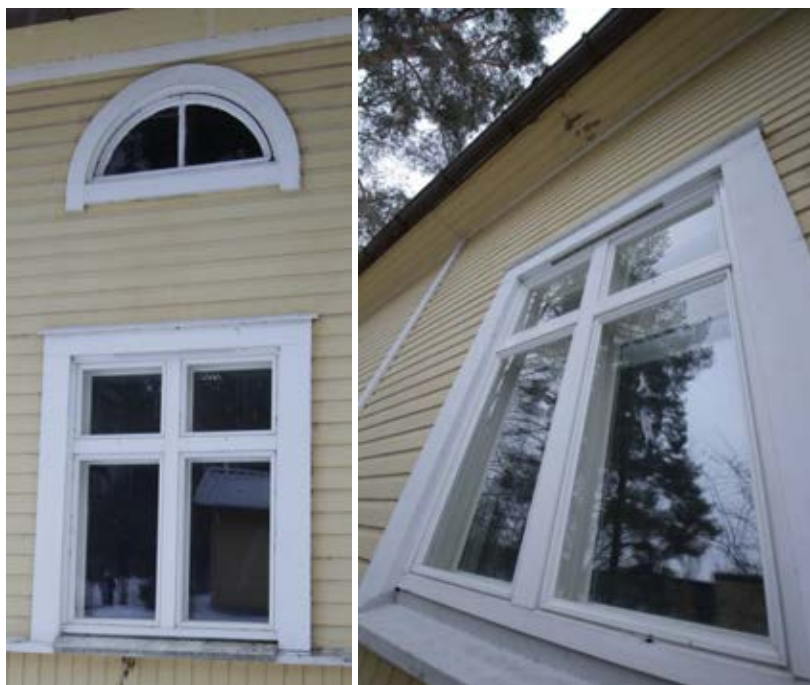
Kuva 97 (vasemmalla). Asuinrakennuksen luoteisjulkisivulla on ullakkokerroksessa puolikuun malliset lunetti-ikkunat kahden reunimmaisen ikkunan yllä.
