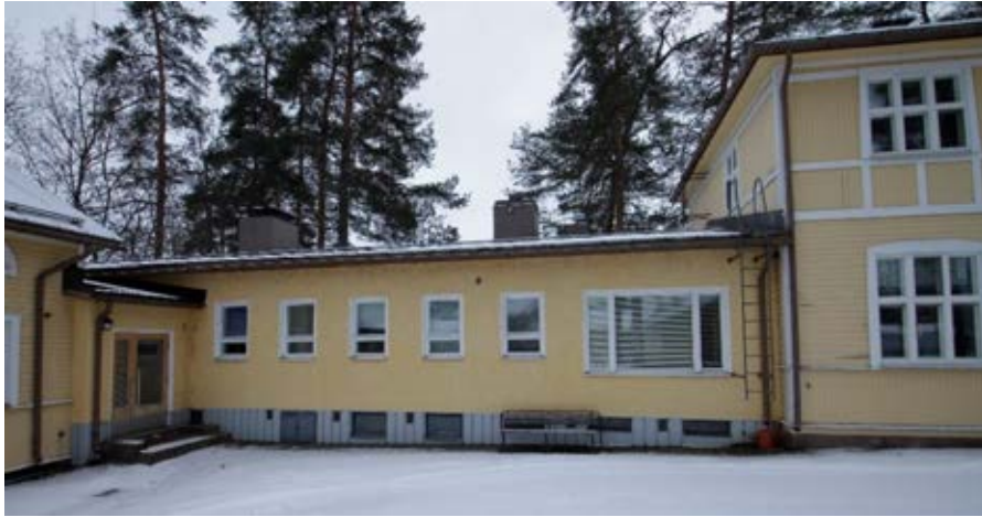
Kuva 45: Laajennusosan pääsisäänkäynti sijaitsee etupihan puolella vasemmassa nurkassa. Pääjulkisivun ikkunat ovat alkuperäiset. Korkea keskuslämmityspiippu on mädallettu 2000-luvulla nykyiseen mittaansa. Kuva: FCG, 2023.
