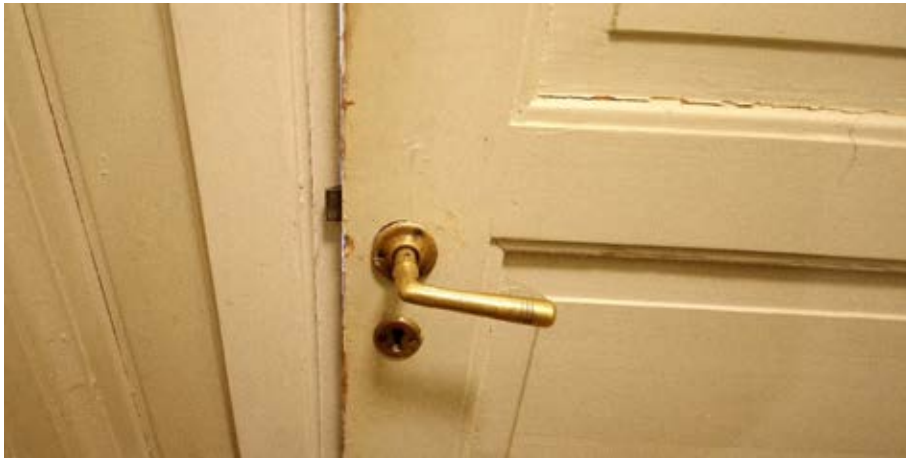
Kuva 143: Huoneen puuovi heloineen on todennäköisesti 1900-luvun alku vuosikymmeniltä. Kuva: FCG, 2023.
