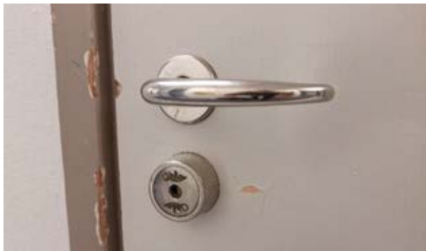
Kuva 152: Suurin osa ovista karmeineen, heloineen ja kynnyksineen on alkuperäisiä. Kuva: FCG, 2023.
