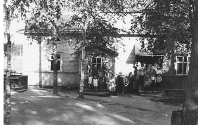
Kuva 34: Vanha asuinrakennus kuvattuna 1945. Maantasokerroksen ikkunoiden yläpuolella erottuvat puolikuun muotoiset lunetti-ikkunat. Rakennuksen pääjulkisivun oikeanpuoleinen lapekattoinen uloskäynti on myöhemmin poistettu käytöstä ja katos purettu. Kuva: Lahden museot, kuvakokoelmat.
