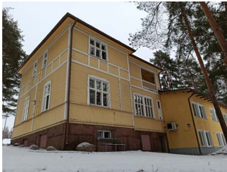
Kuva 122: Kellarikerroksen umpeen muuratut ikkunat erottuvat kivijalassa syvennyksinä Kuva: FCG, 2023.
