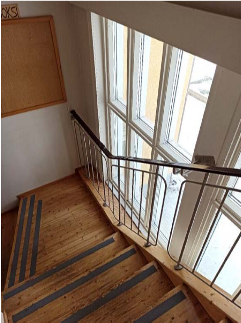
Kuvat 128: Yläkertaan johtavan portaikon harvajakoinen metallikaide ja puiset askelmat ovat todennäköisesti 1950-luvulta, jolloin portaiden paikkaa siirrettiin. Kuva: FCG, 2023.
