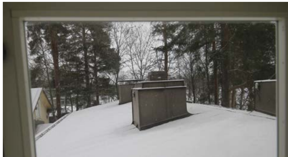
Kuva 64 (vasemmalla yllä). Laajennusosan eteläkulma. Loivan harjakaton räystäiden alukset ovat avonaiset ja kattokannattimet näkyvissä. Niitä on korostettu maalaamalla ne tummiksi.
