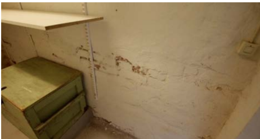
Kuva 121: Kellarin sisäseinien tiilimuuraus kuultaa rappauksen alta. Kuva: FCG, 2023.
