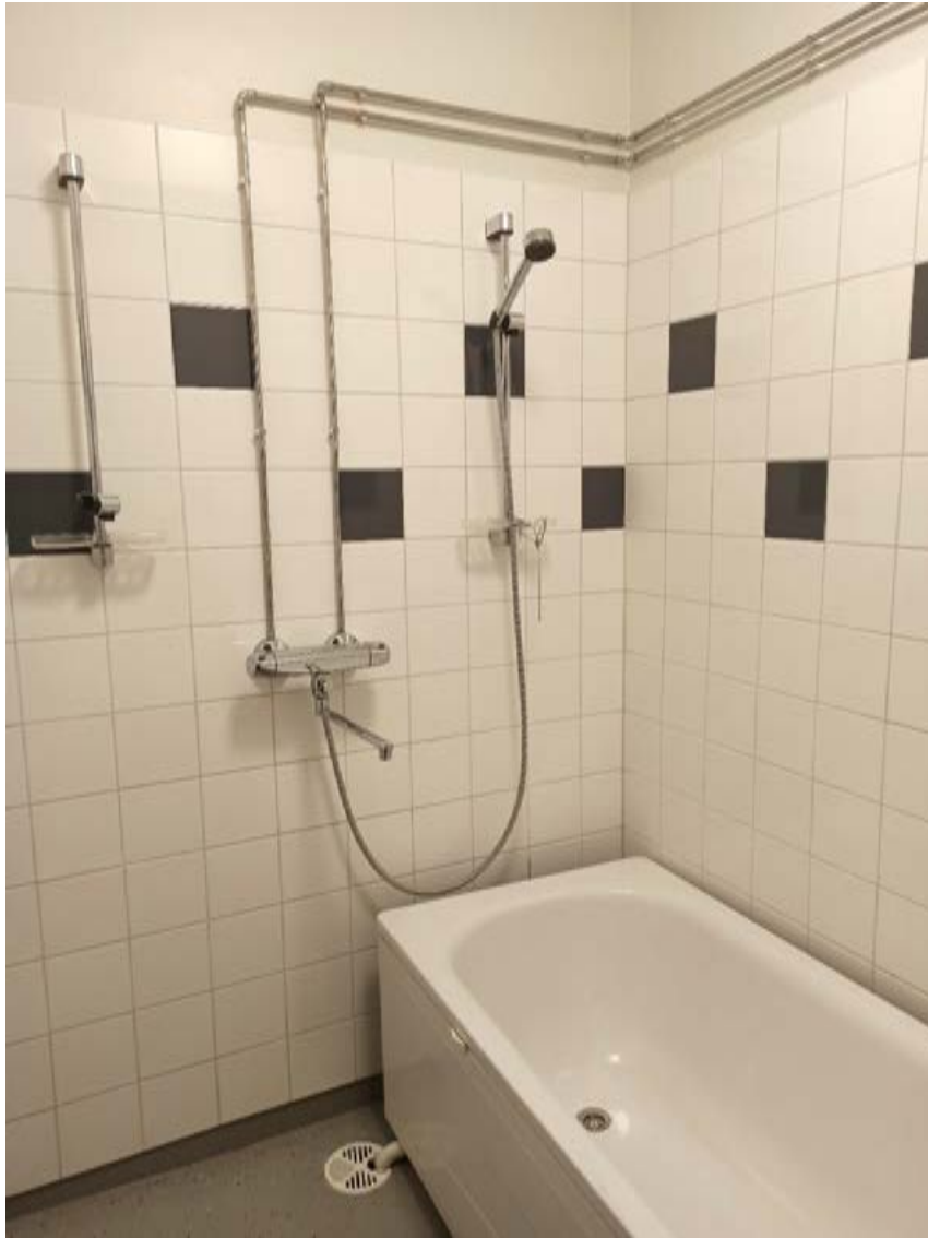
Kuvat 172 ja 173: Kylpyhuoneen, wc:n ja pesuhuoneen pinnat ja kalusteet on uusittu kokonaan tyylin ja kuntonsa puolesta 2010-luvulla. Seinät on osin laatoitettu ja osin maalattu. Betonivälipohjan lattia on pinnoitettu massapäällysteellä. Kuva: FCG, 2023.
