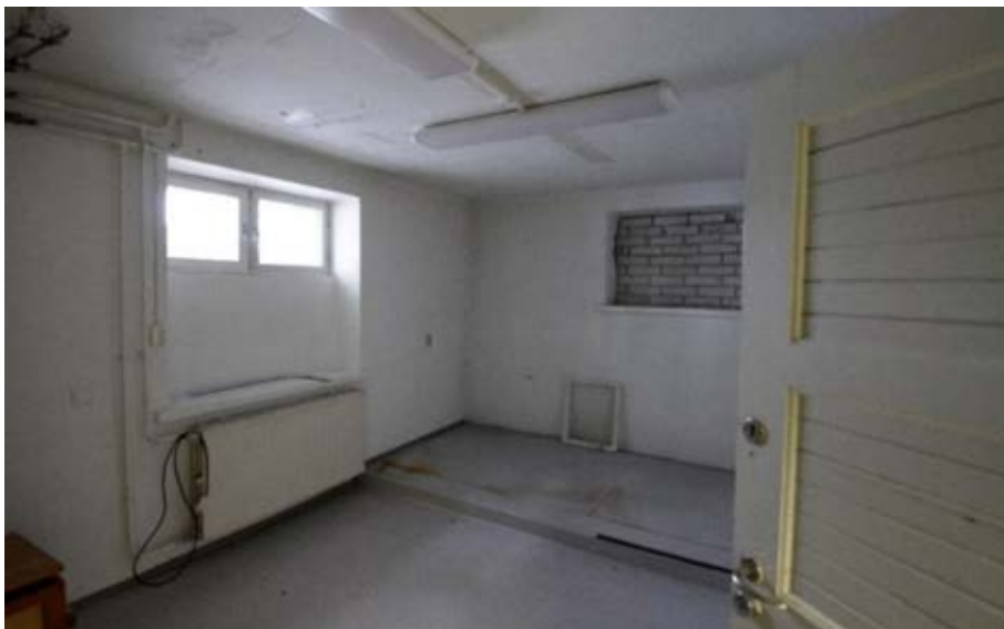
Kuva 120: Askarteluhuoneen ikkunat on osin muurattu kiinni. Ovi on todennäköisesti alkuperäinen. Kuva: FCG, 2023.
