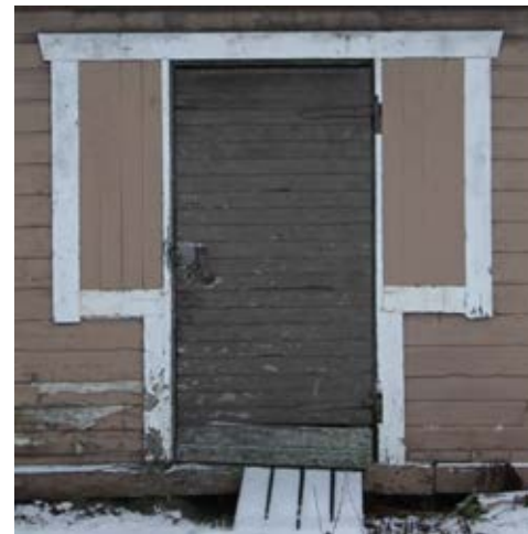
Kuva 56: Vanha varasto ja ulkokäymälä on rakennettu graniittipaasien varaan. Ikkunan viistetyt vuorilaudat ovat samaa tyyliä kuin päärakennuksessa. Toisella puolen varastoa lyhyen päädyn ikkuna on laudoitettu umpeen, vain vuorilaudat ovat jäljellä. Kuva: FCG, 2023.
