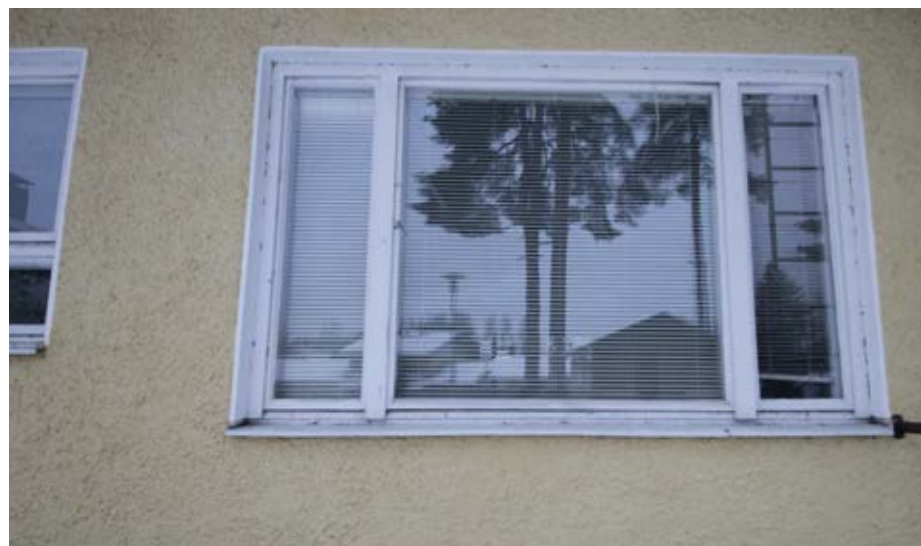
Kuva 99. Laajennusosan koillisjulkisivun isompi ikkuna. Ikkuna on alkuperäinen 1950-luvun ikkuna.
