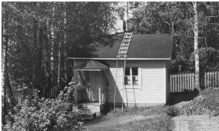
Kuva 51: Hirsinen saunarakennus kuvattuna 1979. Vanha tiilinen savupiippu on sittemmin korvattu metallisella piipulla. Kuva: Harri Haapasalo. Lahden museot, kuvakokoelmat.
