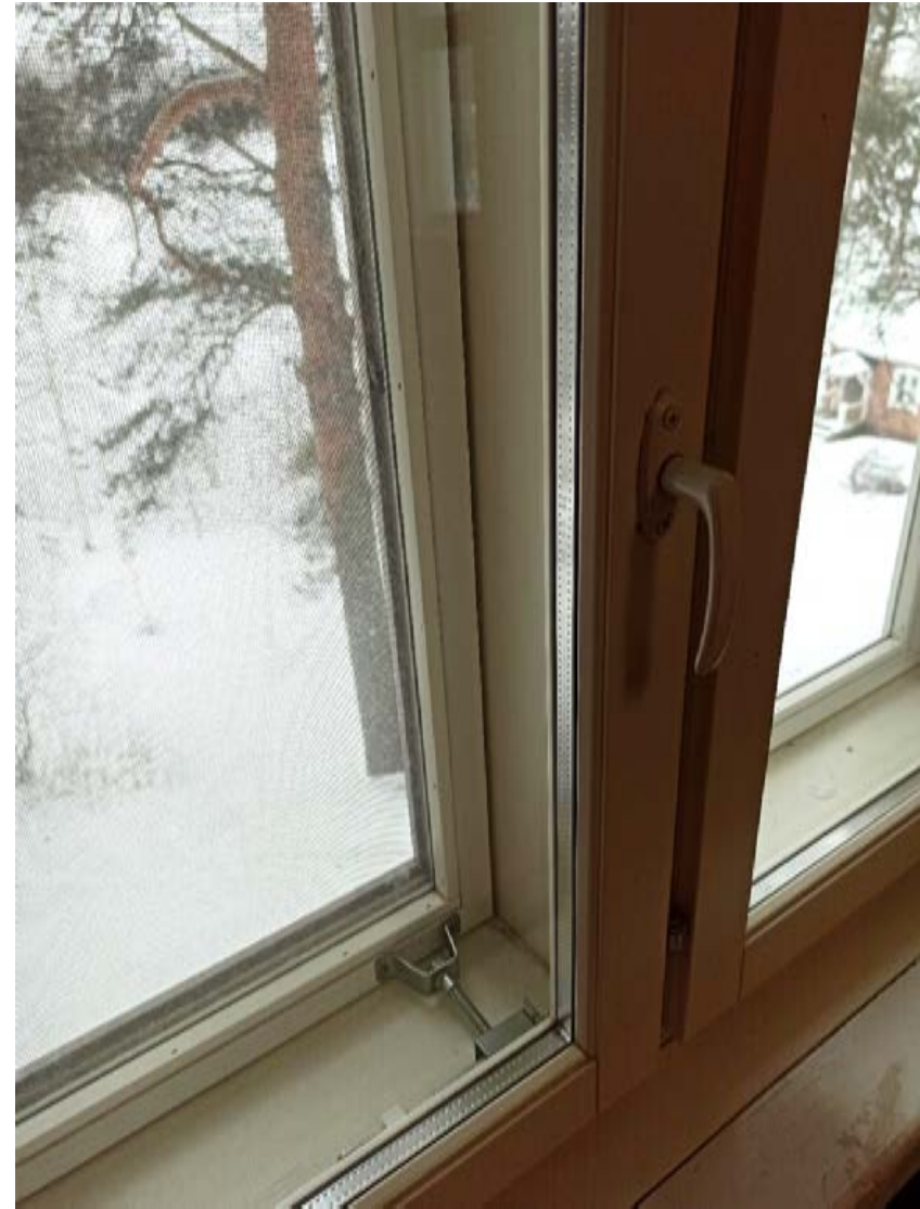
Kuva 129: Ikkunoiden puitteet ja avausmekanismi viittaavat 2000-lukuun. Kuva: FCG, 2023.
