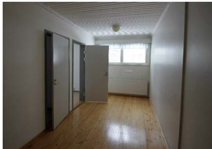
Kuva 131: Yläkerran aulasta avautuu kaksi vierekkäistä ovea pieniin huoneisiin, jotka aiemmin muodostivat yhden ison huoneen. Aulan lattia on lakattua mäntyä ja katto puupaneelia. Kuva: FCG, 2023.
