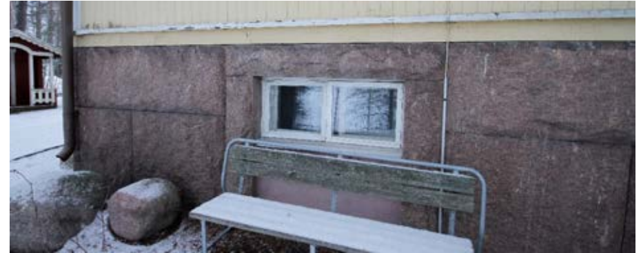
Kuva 32: Punainen graniittikivijalka on säilynyt alkuperäisessä asussaan yli 100 vuotta. Ikkuna-aukkoa on pienennetty muuraamalla alaosa umpeen. Kuva: FCG, 2023.
