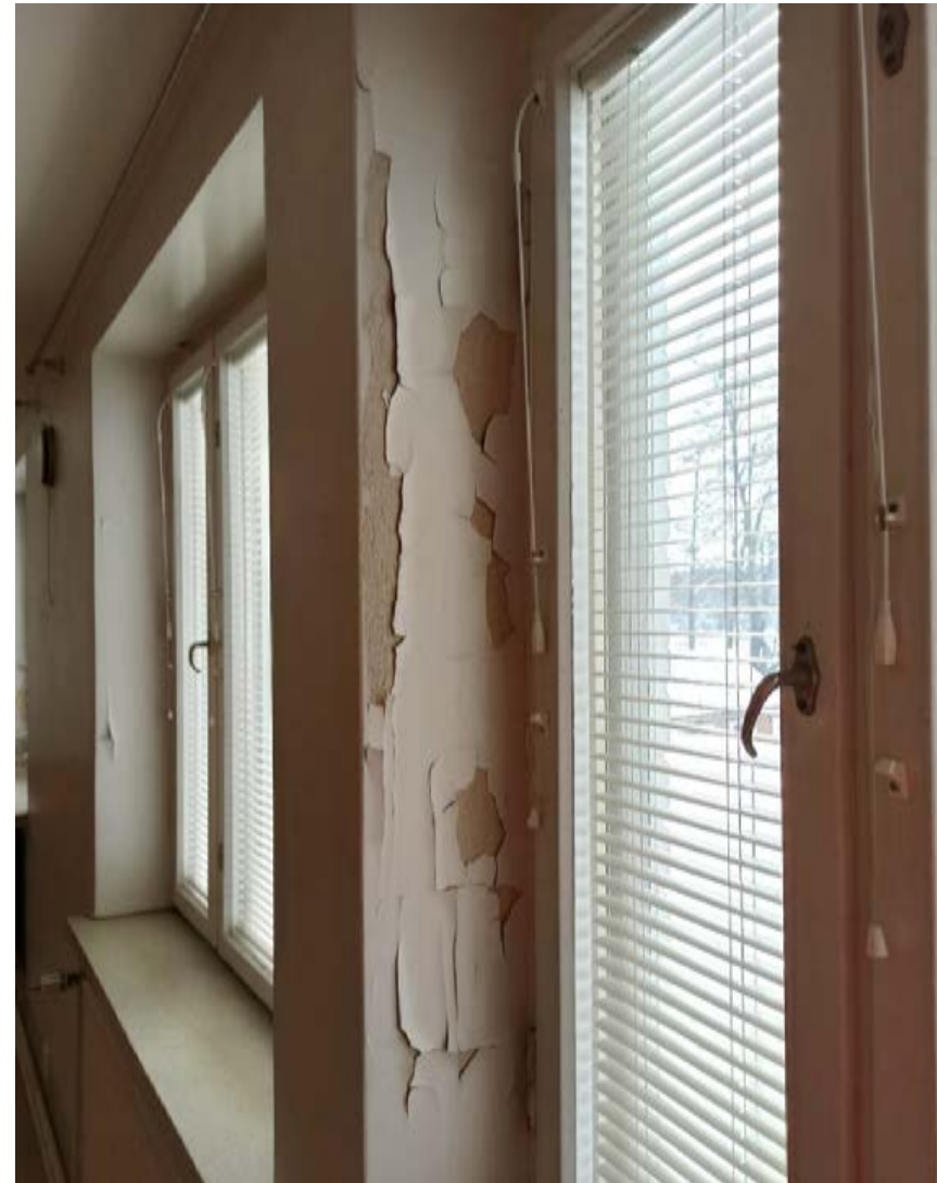
Kuva 155: Päivähuoneessa on avotakka, muovimatto lattianpäällysteenä sekä mäntypuiset puolipaneelit seinillä. Leveä pariovi lieenee alkuperäinen. Ikkunoiden vierustoilla maali kuoriutuu pois tilirungon tasoitteen päältä. Kuva: FCG, 2023.
