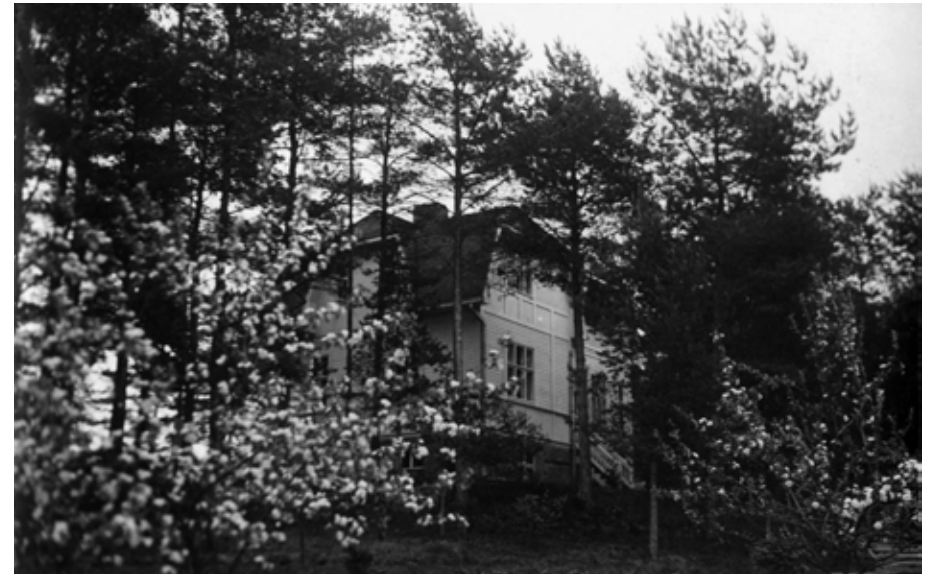
Kuva 33: Valokuvassa erottuvat takapihan puolen taitekattoiset, osin aumatut poikkipäädty, ulko-ovi sekä jyrkät portaat. Portaat on sittemmin purettu pois ja katto-muoto muutettu loivaksi aumakatoksi. Kuva on ajoitettu Lahden museoissa vuodelle 1945. Kuva on kuitenkin todennäköisesti vuodelta 1927. Tälle vuodelle on ajoitettu Lahden kuvakokoelmiin kuuluva hieman etäämmältä otettu rinnakkaisotos kuvasta. Kuva: Lahden museot, kuvakokoelmat.
