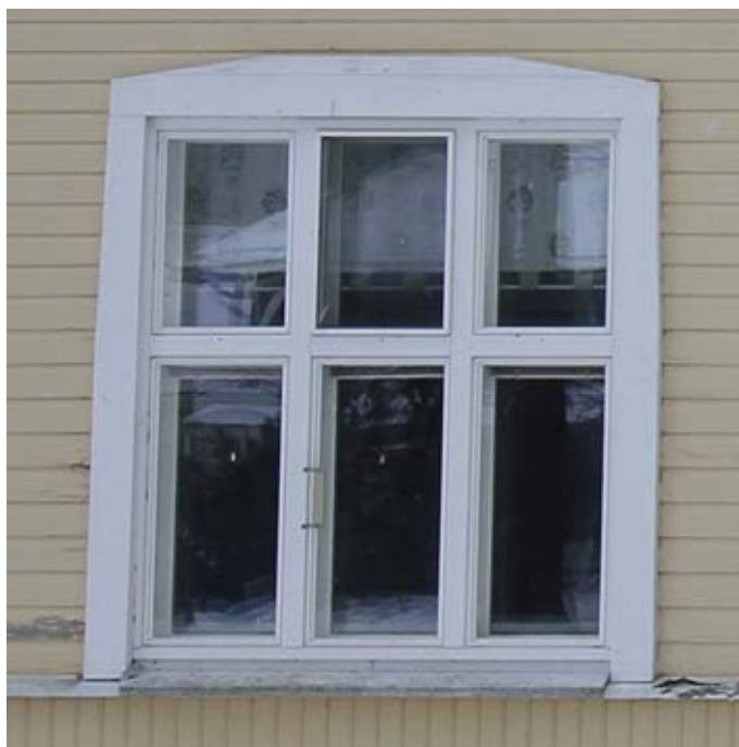
Kuva 91. Päärakennuksen ikkunat ovat pääasiassa levennettyjä risti-ikkunoita. Ku-vassa on koillisjulkisivulta alakerran ikkuna. Yläkerrassa ikkunat ovat malliltaan hie-man matalampia. Luoteisjulkisivulla ikkunat ovat risti-ikkunoita.
