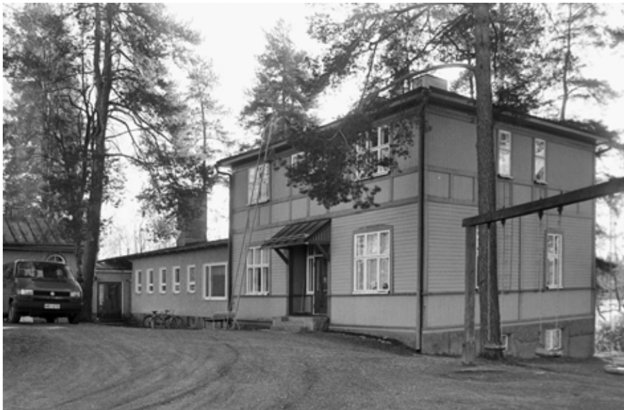
Kuva 36: Vuoden 1999 valokuvassa laajennusosan korkea keskuslämmityspiippu on vielä alkuperäisessä korkeudessaan. Päärakennuksen päretaitekatto poikkipäättyineen on vaihdettu peltiseen aumakattoon. Kuva: Lahden museot, kuvakokoelmat.
