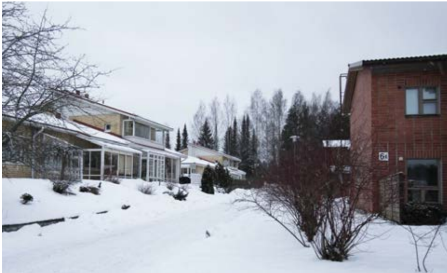
Kuva 103. Naapuruston 1980-luvun rivitaloja Huhmarannankadun pohjoispuolelta.
