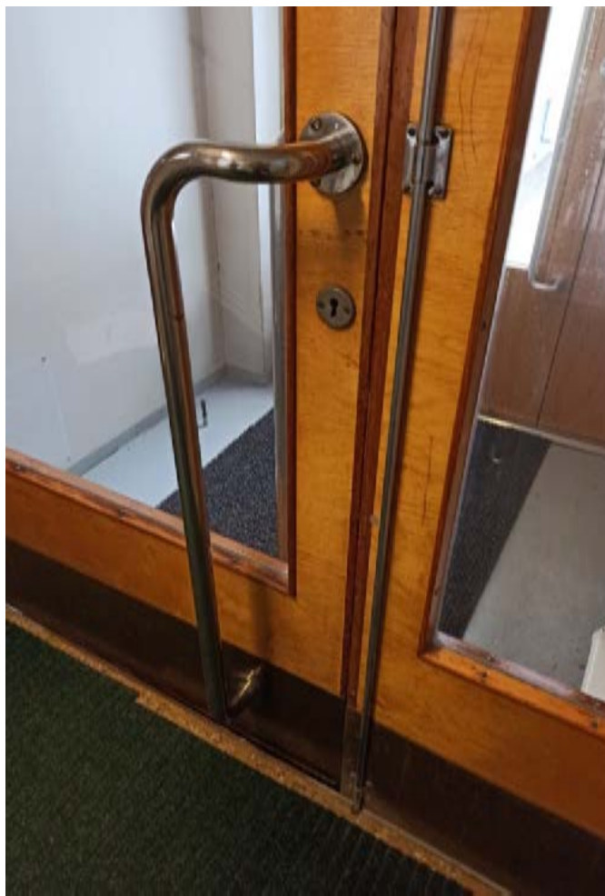
Kuva 178 (vasemmalla): Rakennuksen kellari-kerroksen ulko-ovi on käsitelty tummapintaiseksi. Taivutettu metalliripa on tyypillinen 1950-luvulle.
