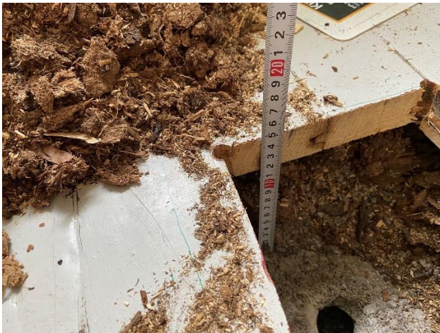
Kuva 4. Pukuhuoneen keskialueelle tehty avaus
