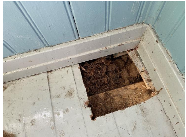
Kuva 5. Nurkkaan tehty rakenneavaus
