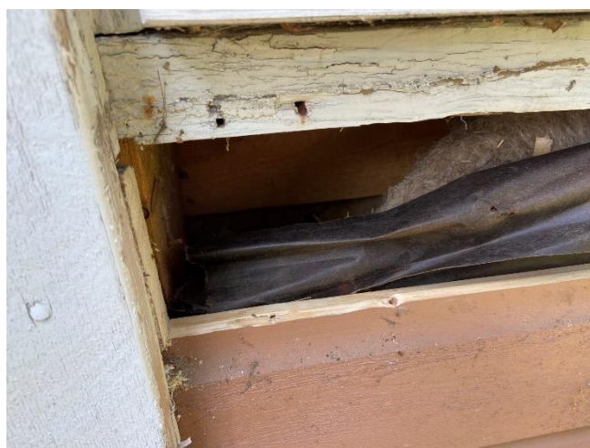
Kuva 9. Saunan löylyhuoneen takaseinän lämmöneristettyä seinää
