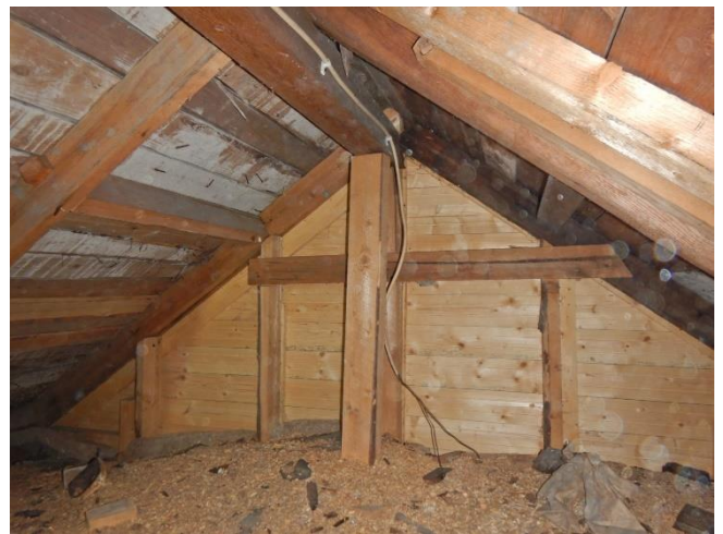
Kuva 14. Päätykolmiot on uusittu ulkoverhouksen uusimisen yhteydessä.
