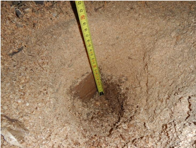
Kuva 15. Purueristekerroksen alla on n. 50 mm turvekerros.
