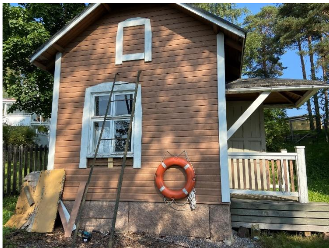
Kuva 6. Järven puoleinen julkisivu
