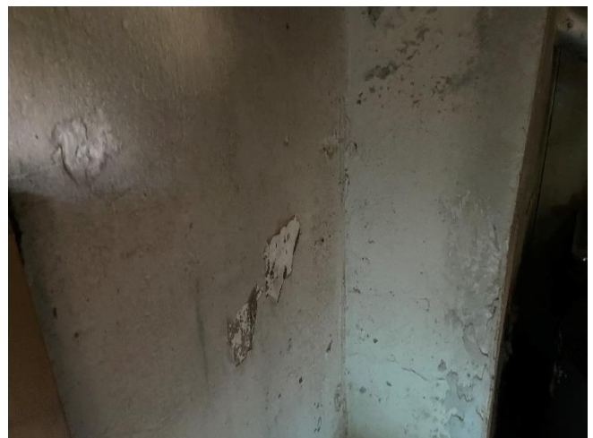
Kuva 2. ASB2 palomuurin maali + rappaus ei sisällä asbestia
