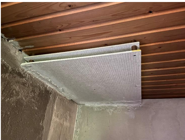
Kuva 1. ASB1 kiukaan palonsuojalevy ei sisällä asbestia
