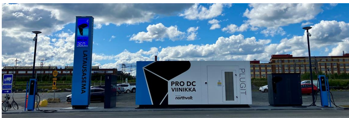
Kuva 7. Tampereella sijaitseva suurteholatausasema.
