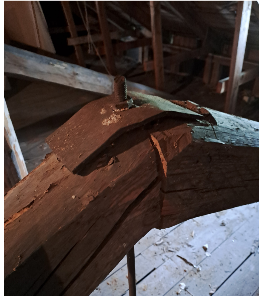
Kuvat 51-52: Rakennekuvista poiketen ullakolla näkyvä paikalla tehty kattoristikkorakenne ei ole aivan tavanomainen. Rakennuksen kummallekin pitkälle sivulle muodostuu oma pienempien kattotuolien harjalinjansa, ja välipohjassa kulkevat kantavat palkit on ripustettu ristikon harjakohdista metallisin läpivetotapein. Kuvattu 21.05.2025. Kuvaaja Heidi Kontulainen.
