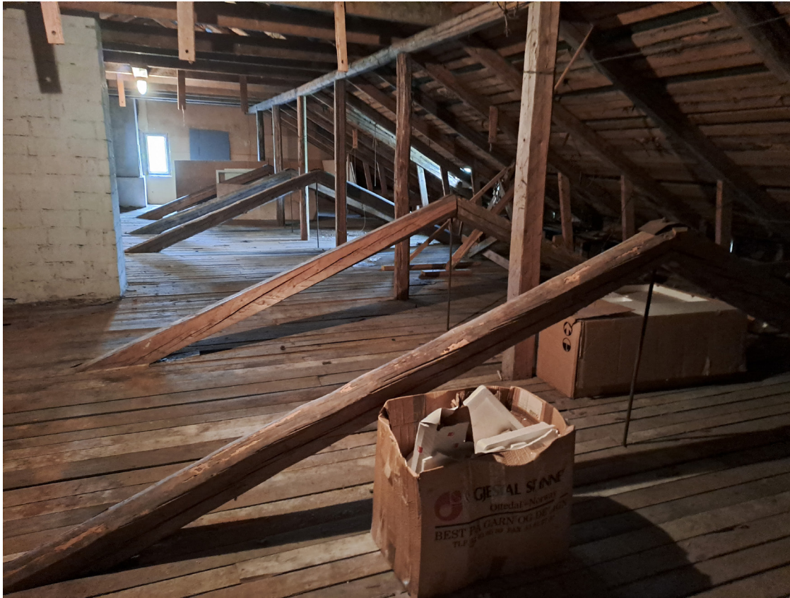
Kuvat 51-52: Rakennekuvista poiketen ullakolla näkyvä paikalla tehty kattoristikkorakenne ei ole aivan tavanomainen. Rakennuksen kummallekin pitkälle sivulle muodostuu oma pienempien kattotuolien harjalinjansa, ja välipohjassa kulkevat kantavat palkit on ripustettu ristikon harjakohdista metallisin läpivetotapein. Kuvattu 21.05.2025. Kuvaaja Heidi Kontulainen.
