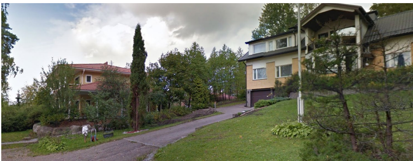
Tuomistontie 51 asuinrakennus oikealla. Takana näkyy Omarannankatu 8:n asuinrakennus.
