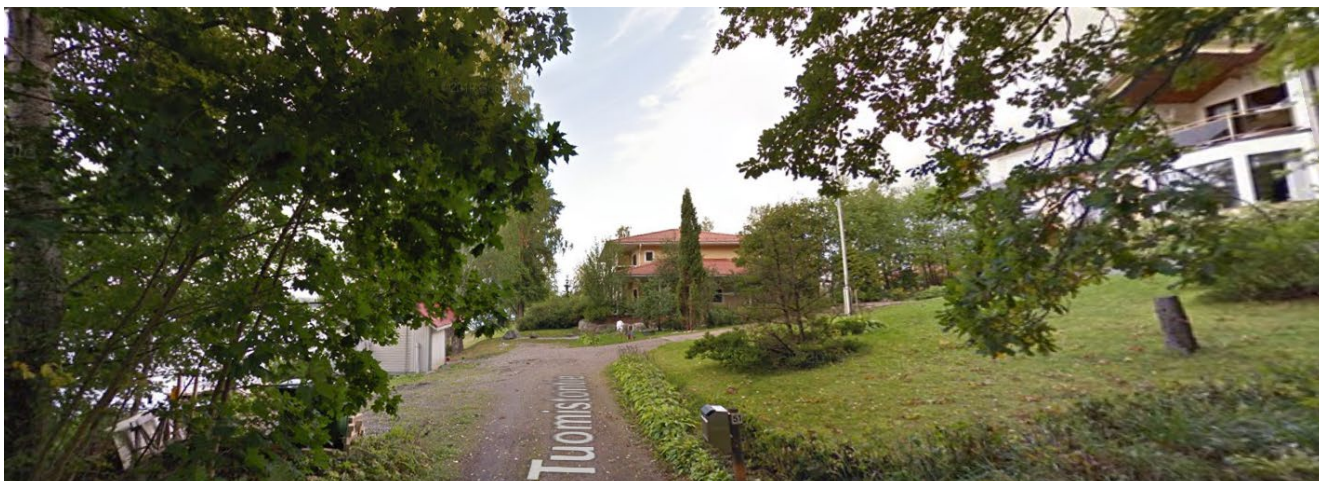
Tuomistontie 51 asuinrakennus ja rantasauna. Takana näkyy Omarannankatu 8:n asuinrakennus.
