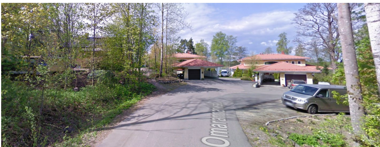
Tuomistontie 51 asuinrakennus vasemmalla, Omarannankatu 8 keskellä ja Omarannankatu 10 oikealla. Kaikille tonteille johtaa ajoyhteys Omarannankadun kautta.
