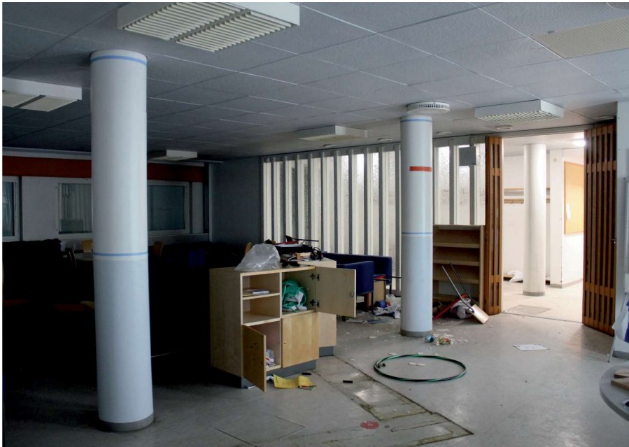
Kuva 118. Opettajainhuone. Kuva H&M Arkkitehdit
