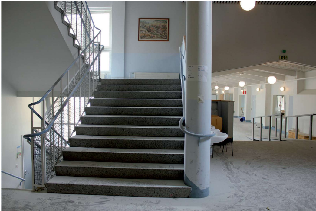
Kuva 93. Näkymä itäkäytävästä pohjoispäädyn portaikkoon ja pääaulaan. Kuva H&M Arkkitehdit.
