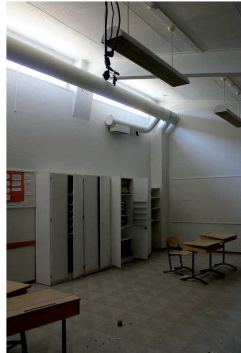
Kuva 76. IV-kanavat peittävät 3. kerroksen opetustilojen yläikkunoista tulevaa luonnonvaloa. Kuva H&M Arkkitehdit.
