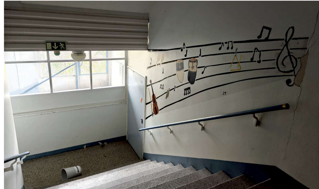
Kuva 113. Kulku musiikkiluokkaan. Opetustila sijaitsee puoli kerrosta alempana länsikäytävästä. Kuva H&M Arkkitehdit
