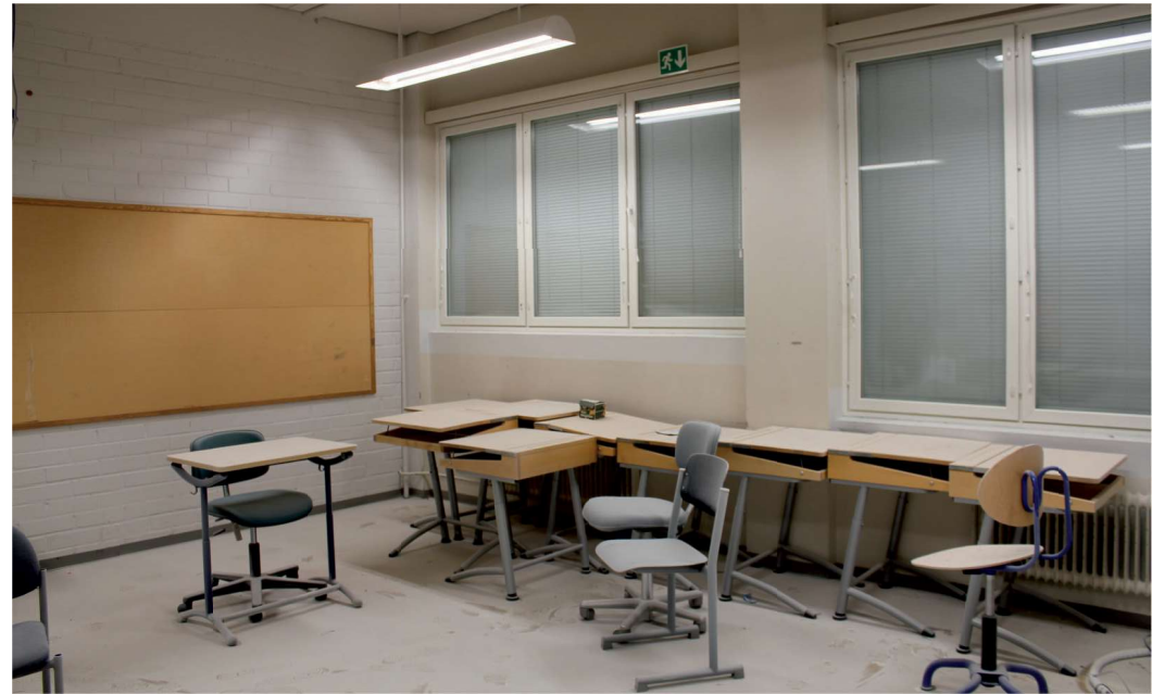
Kuva 108. Opetustilojen pienentämiset ovat johtaneet tilanteeseen, jossa ikkunat eivät enää noudata tilajakoja. Kuva H&M Arkkitechdit.
