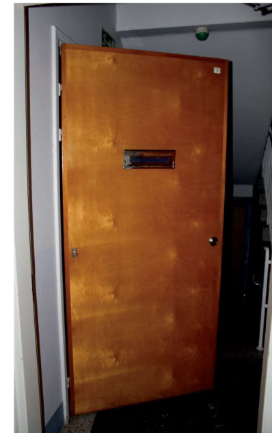
Kuva 122. Entisten asuntotilojen alkuperäinen ovi. Kuva H&M Arkkitehdit
