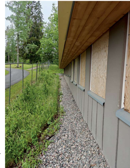
Kuva 30. Henkilökunnan tilojen ulkoseinää etelään päin. Kuva H&M Arkkitehdit.
