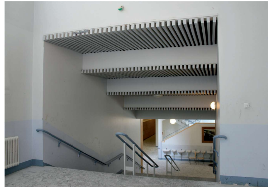
Kuva 52. Katon ritiläelementtejä Juhlasaliin johtavassa portaassa. Kuva H&M Arkkitehdit.
