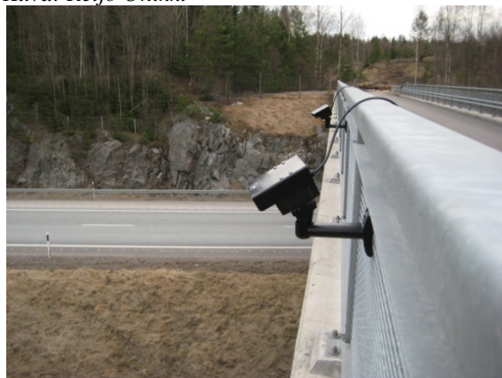
Kamerat kiinnitettynä ylikulkusillan kaiteeseen
