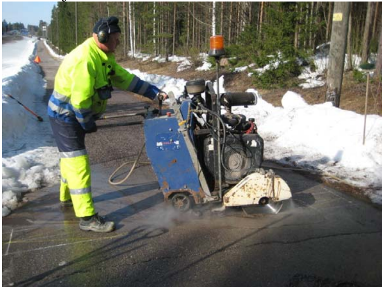
Kuva 1. Silmukoiden sahausurat tehtiin keskiraskaalla sahauskalustolla.
