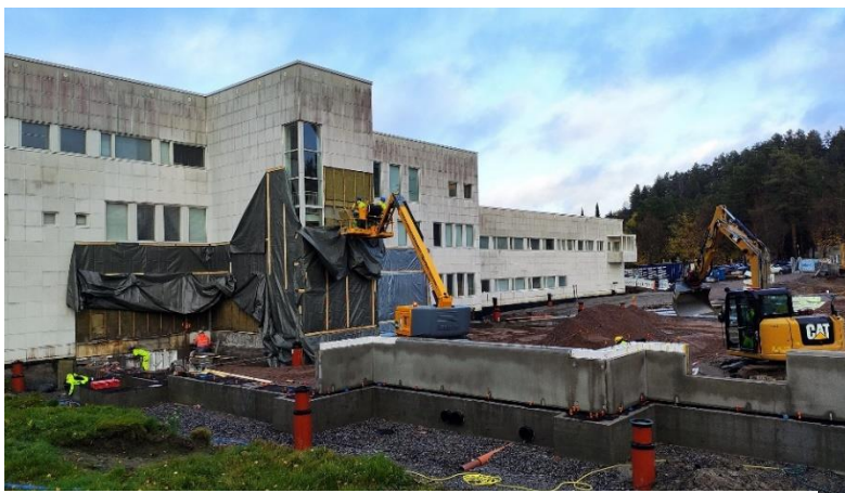
KK16 aikuiskoulutuskeskuksen ulkoseinän julkisivun purkua ja sokkelielementtejä asennettuna
