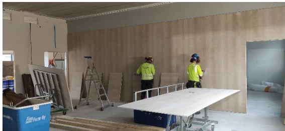
KK22 A-osan 2.krs ontelolaattakentän ja runkoelementtien asennusta. B-osalla 3.krs väliseinien ylilevytystyö käynnissä.
