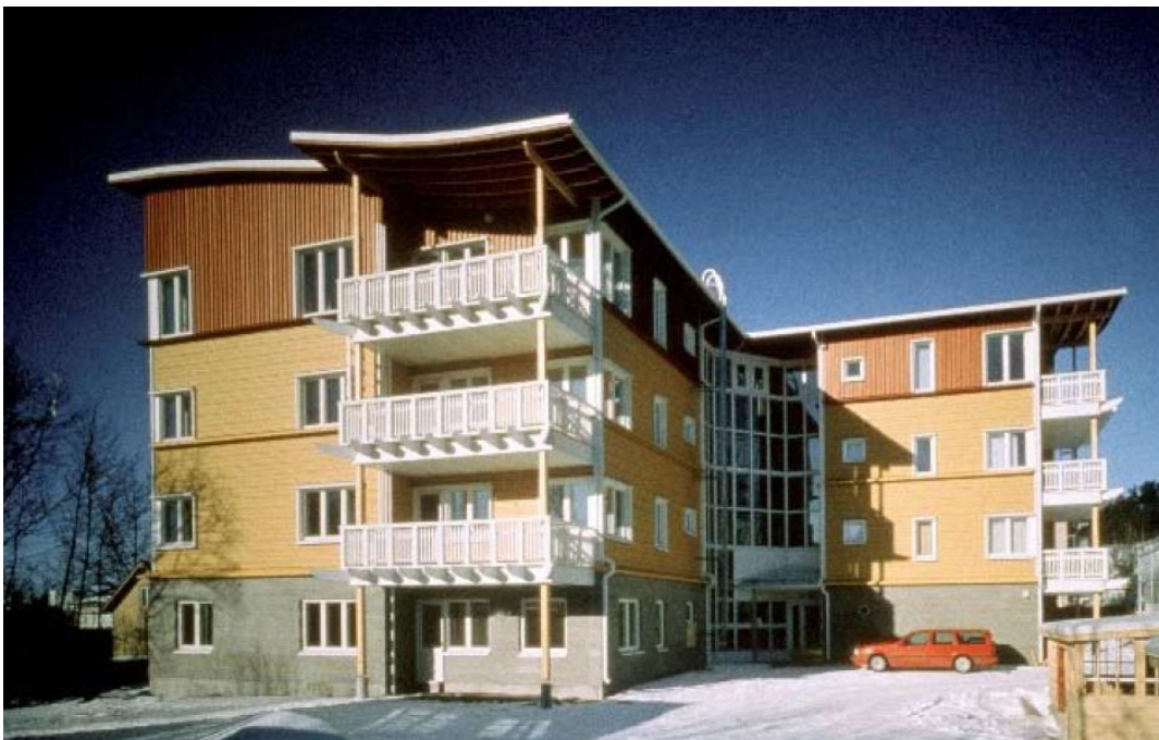
Kuva 2. Nelikerroksinen puurunkoinen kerrostalo Lahdessa. (Lahtela 2021)
