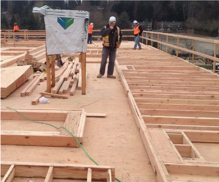
Kuva 3. Platform-rakentamista. (Lahtela 2021)
