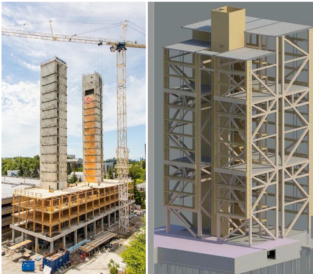
Kuva 8. Hissikuilun toteutus betoni - ja puurunkoisena. (Lahtela 2021, 36, 43).
