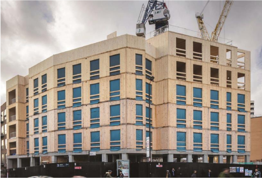
Kuva 5. Massiivipuulevyratkaisu puukerrostalon runkorakenteena. (Lahtela 2021)
