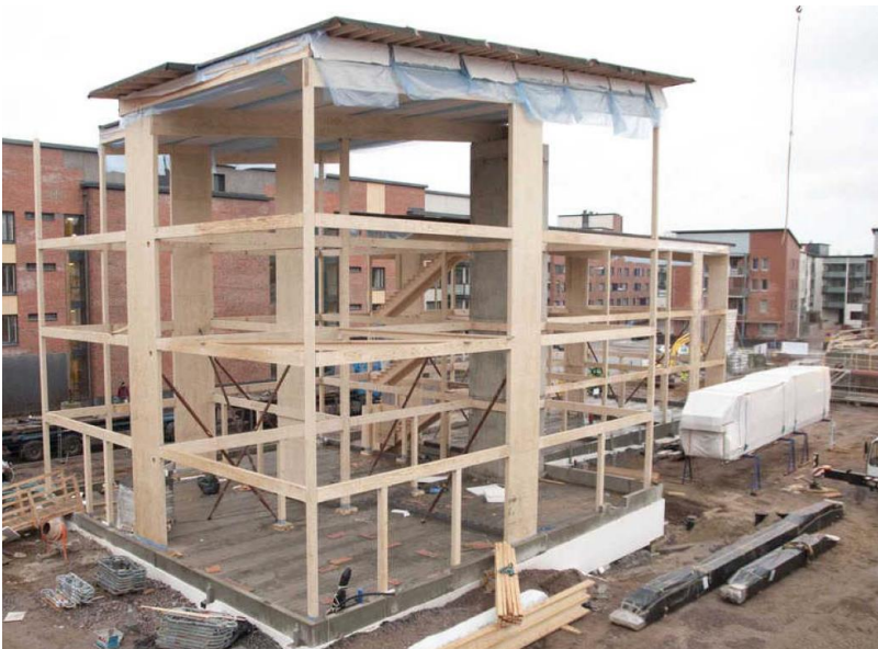
Kuva 6. Kerrostalon runkototeutus pilari-palkkimenetelmällä. (Lahtela 2021)
