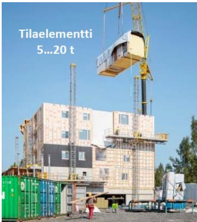
Kuva 7. Tehtaalla valmistetun tilaelementtipuukerrostalon kokoonpanoa. (Lahtela 2021)
