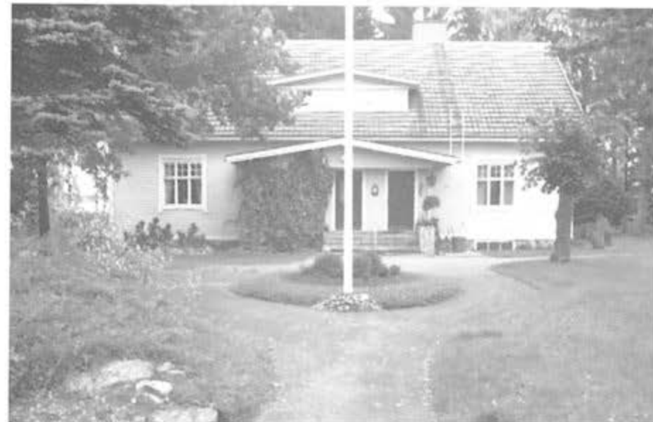
ASUINRAKENNUS PIHAPIIREINEEN Tupalankatu 14
