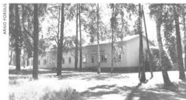
VUONNA 1943 VALMISTUNUT KULKUTAUTISAIRAALA PURETTU
