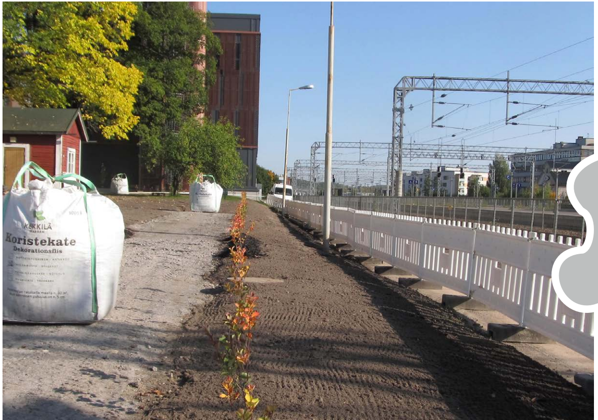
Asemapäälliköntalon puistikon siisti viherrakennustyömaa radan vieressä 2017. Kuva Eila Palojärvi
