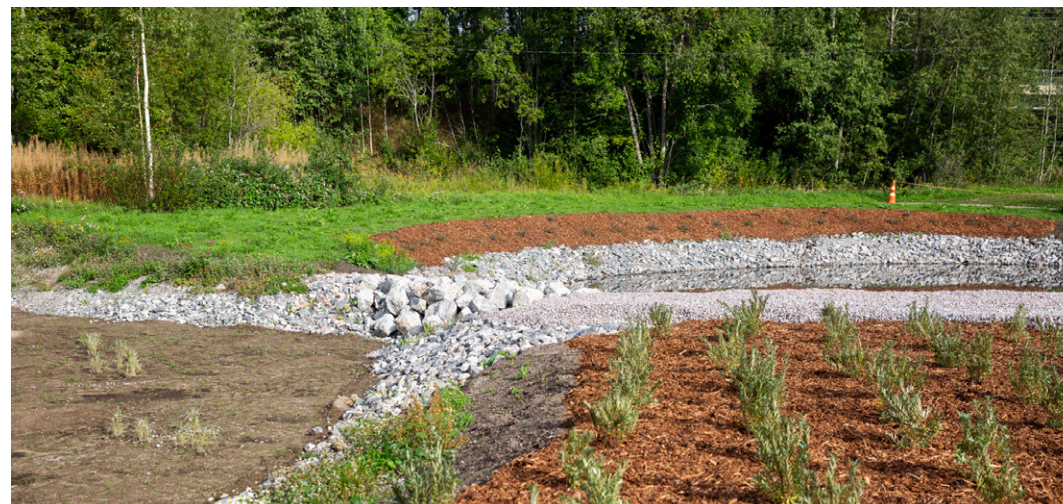
Kuva 8. Hulevesien imeytys Hennalassa.
