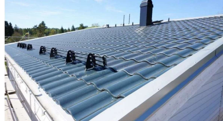
Sähköä tuottava e-Tiili (Kuva: Ralos)
