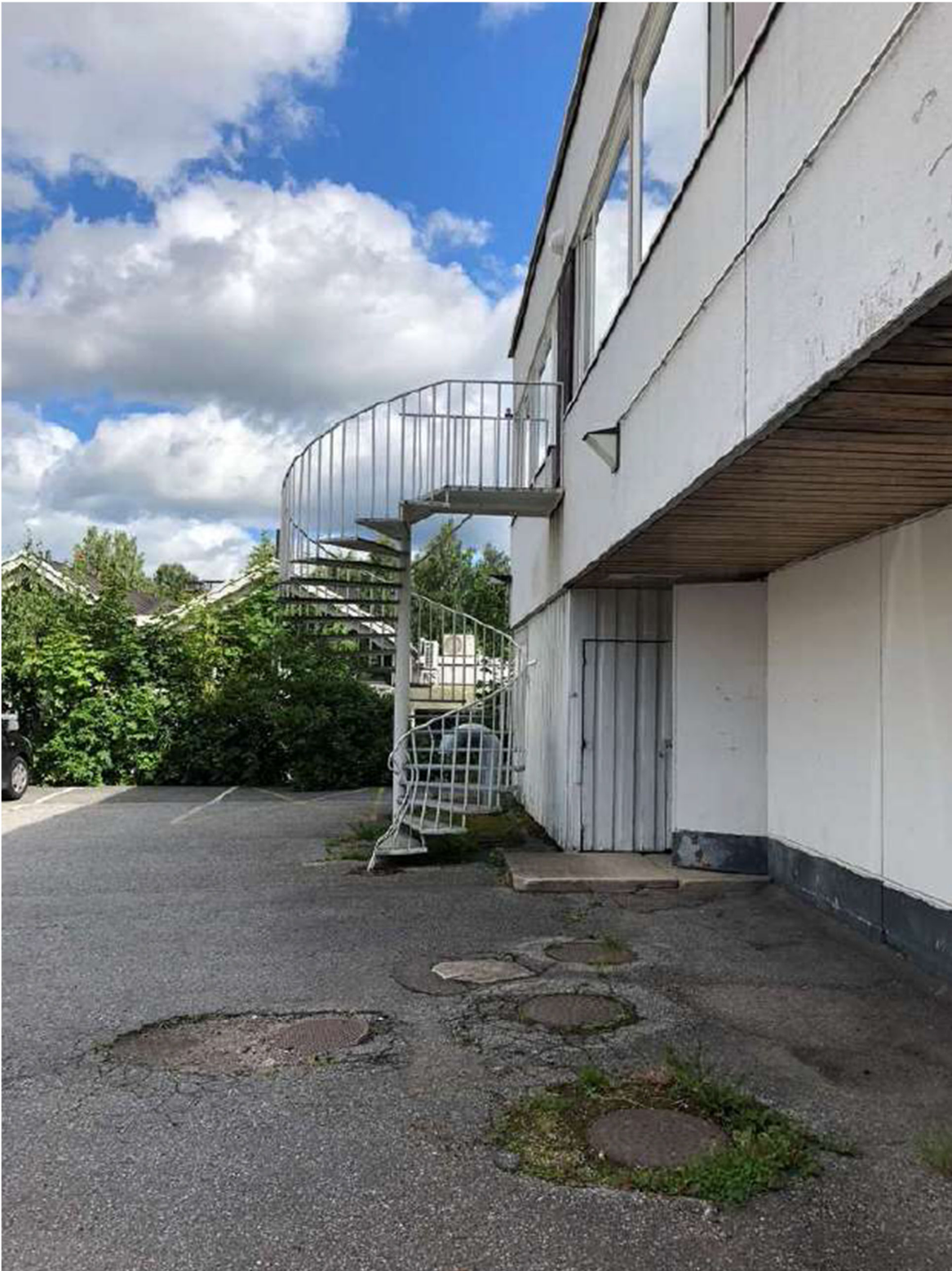
Varasto muuttaa myös näkymiä ja reittiä rakennuksen takaa pysäköintialueelta katetulle kulkuväylälle. (Kuva: Jonna Haikonen/Henna Aspegren).
