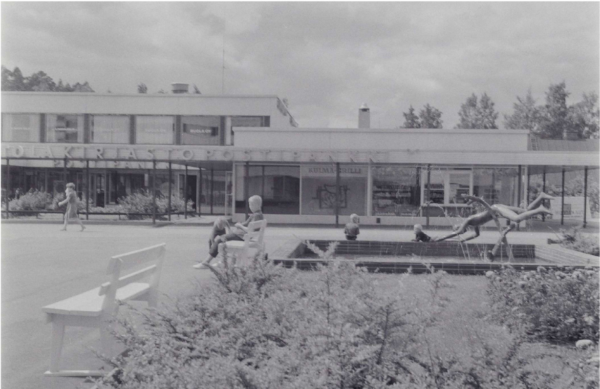
Ruolan ostoskeskus. Kuva vuodelta 1967. Työväen arkiston valokuvakokoelmat. Toisessa kerroksessa Rakennustoimisto Ruola Oy:n toimistotila.
