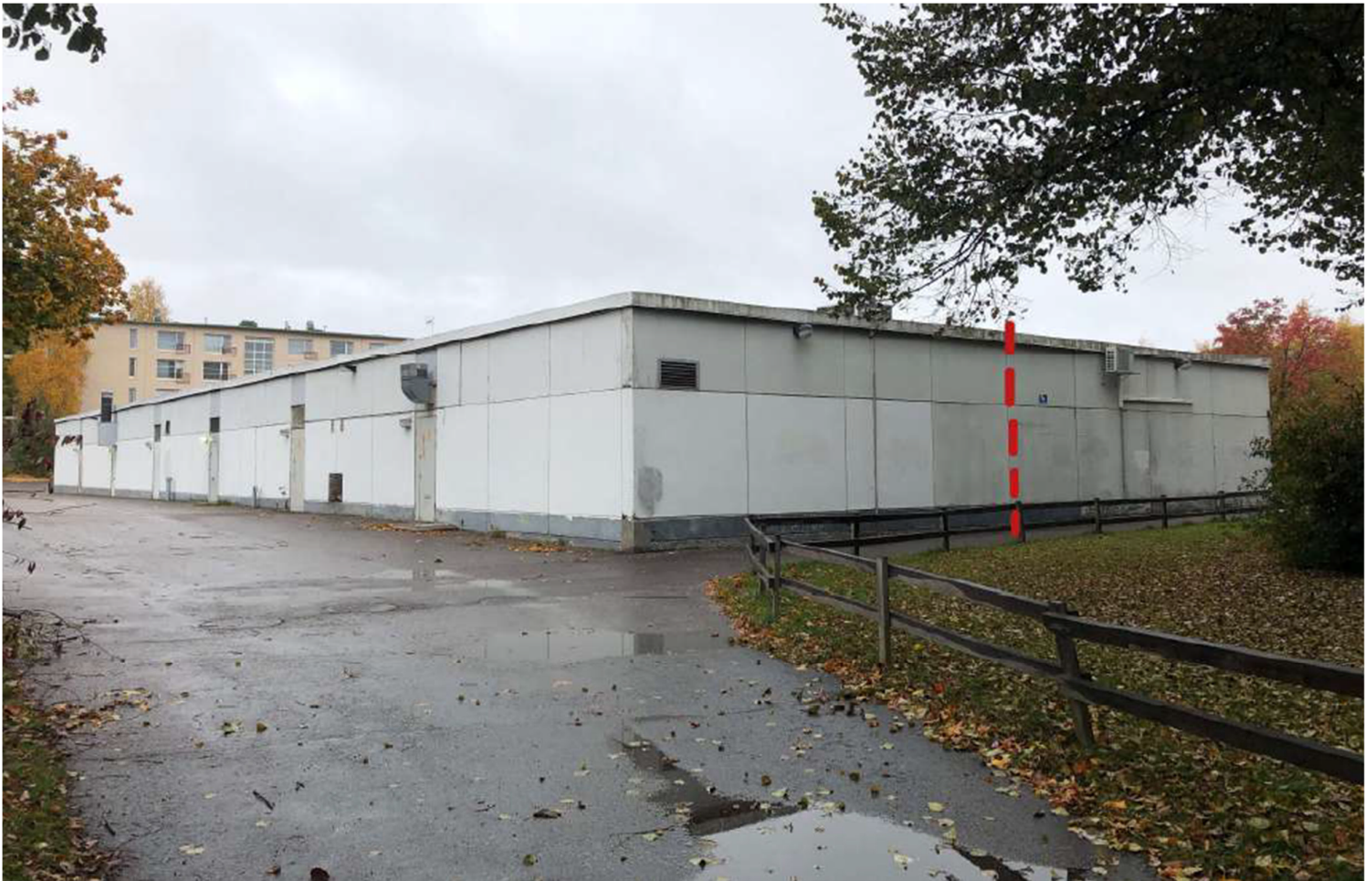
Laajennuksen myötä rakennuksen päädyn syvyysmitta on kasvanut kaksinkertaiseksi ja näkymä raitilta lähestyttäessä on muuttunut oleellisesti. Punaisella katkoviivalla merkityn rakennuksen alkuperäisen julkisivupinnan linjan etupuolella näkyi raittia pitkin lähestyttäessä katoksen reuna. (Kuva: Jonna Haikonen/Henna Aspegren).
