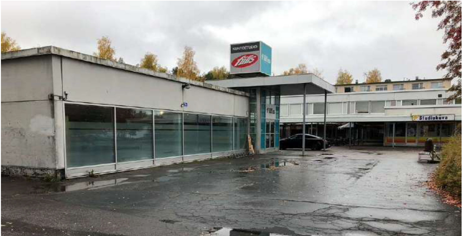
Laajennuksen muusta räystäspinnasta korotettu sisäänkäynti ja teräspilareilla kannatettu erillinen katos ei ole rakennuksen alkuperäistä ideaa vastaava. (Kuva: Jonna Haikonen/Henna Aspegren).
