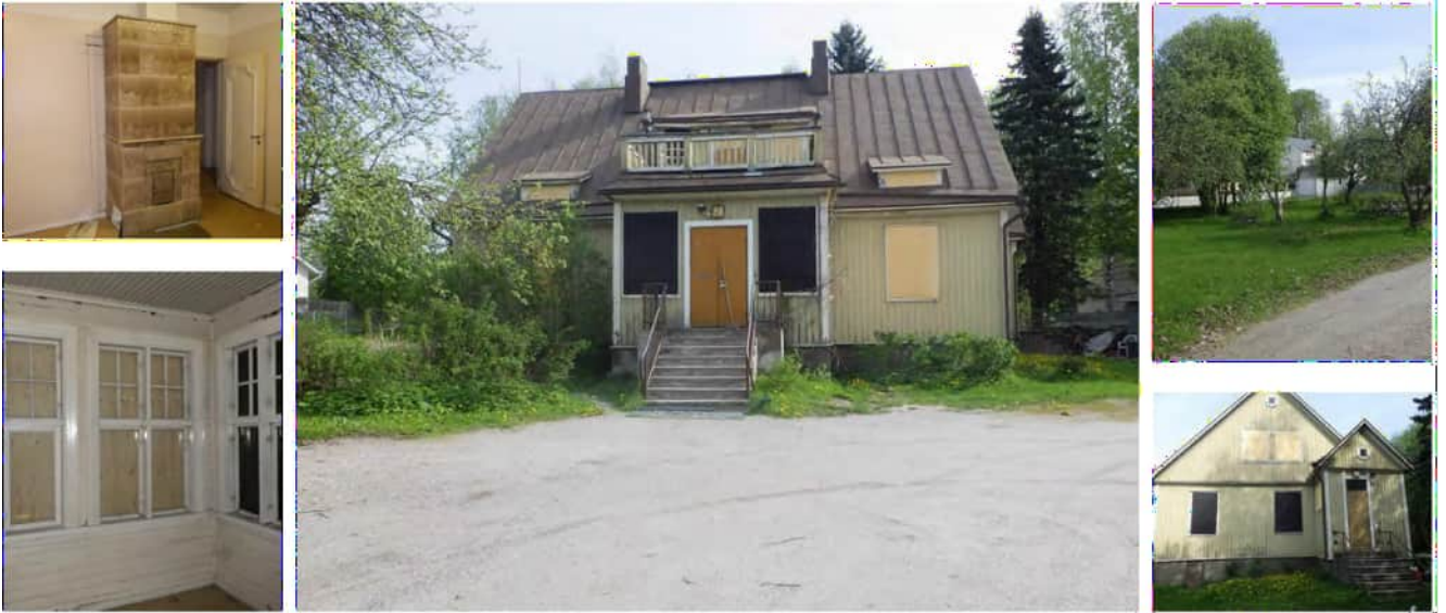
Kuva 9. Suunnittelualueella sijaitsee vuonna 1927 valmistunut hirsirunkoinen lautaverhoiltu asuinrakennus. Rakennus on tällä hetkellä tyhjiillään.
