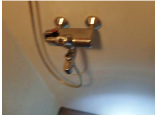
73. Yläkerran suihkutiloille vesijohdot seinästä.
