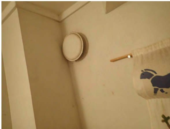
91. Poistoilmaventtiili.
