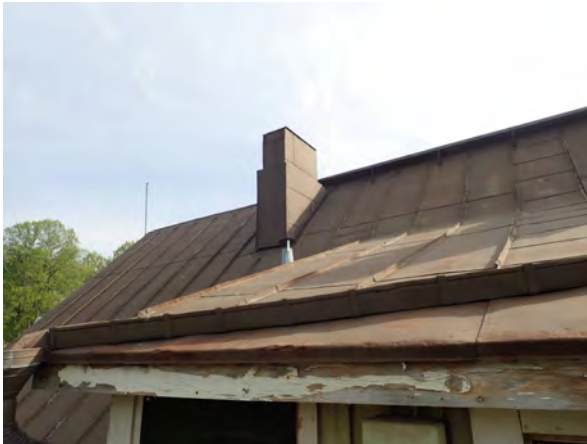
85. Hormipiippujen päihin olisi hyvä lisätä sadehatut.
