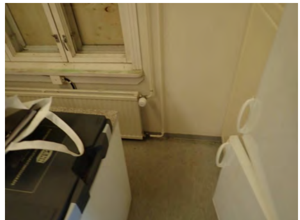
65. Termostaattinen patteriventtiili uusittu.
