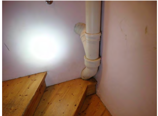
76. Viemäri portaissa, alaspäin vanhaa valurautaa, yläkerran sivuliittymä muoviviemäriä.
