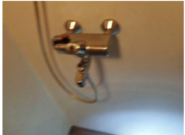
82. Suihkusekoittaja oletettavasti vuodelta 1983.
