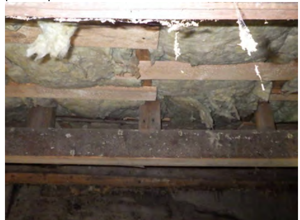
24. Alapohjaan on lisätty myös villaeristettä.
