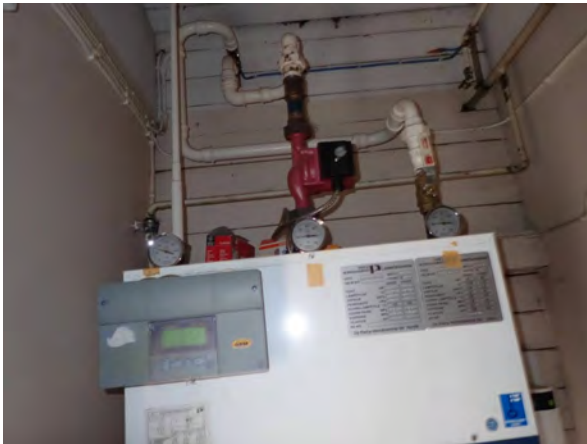
59. Lämmönsiirrinpaketti.
