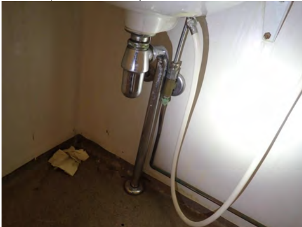
72. Yläkerran wc:lle vesijohdot seinästä.
