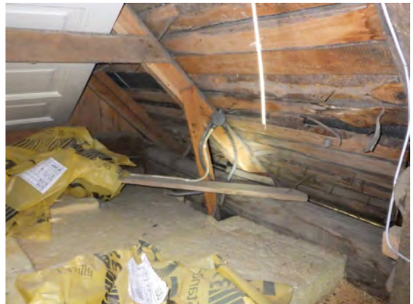
48. Kylmiin ullakkovarastoihin on lisätty villaeristettä.
