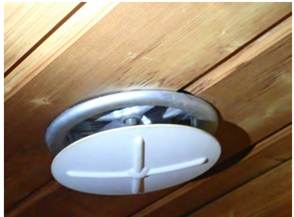
92. Poistoilmaventtiili.
