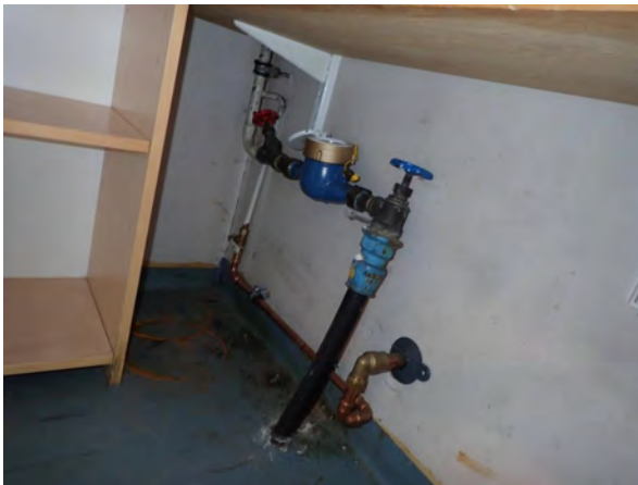
69. Kiinteistön päävesimittari.
