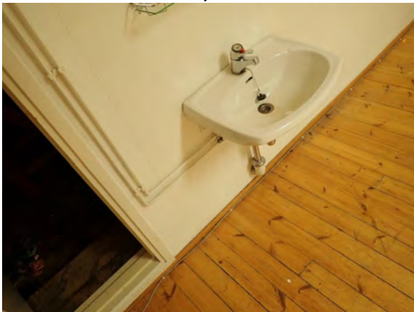
74. Yläkerran pesualtaalle vesijohdot pinta-asenteisina.
