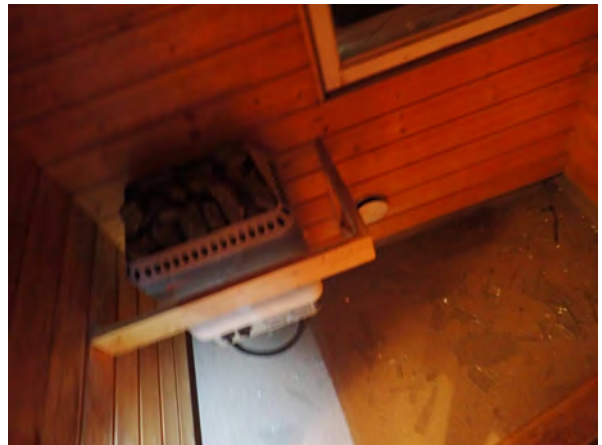
94. Saunassa on korvausilmaventtiili.
