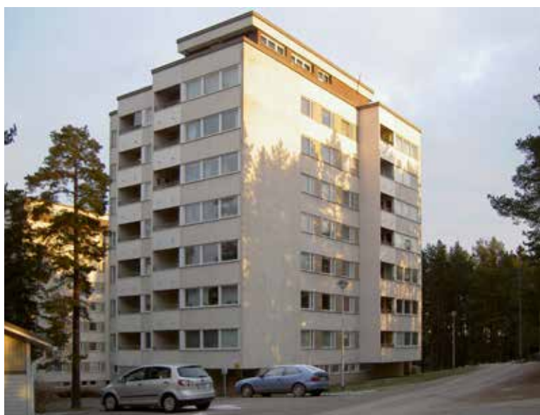
Kuva 41. C-rakennuksen julkisivua parvekekorjauksen jälkeen.
