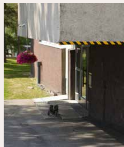
Kuva 35. Sokkelin rouhepintaa, porrashuoneen toinen sisäänkäynti.
