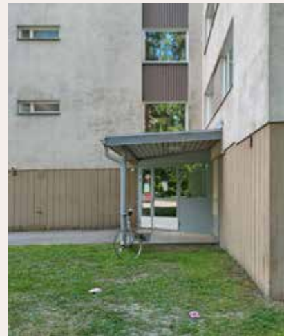
Kuva 33. Tuulikaappi ulkoa. Maalattua sokkelipintaa.
