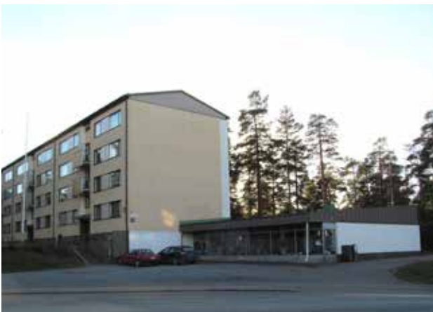
Kuva 56. Rakennus A Kiveriönkadulta.
