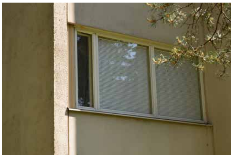
Kuva 47. Ikkunaa ja julkisivupintaa lähempää.
