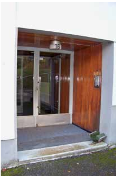
Kuva 63. As Oy Vuokkomäki, sisäänvedetty sisäänkäynti.
