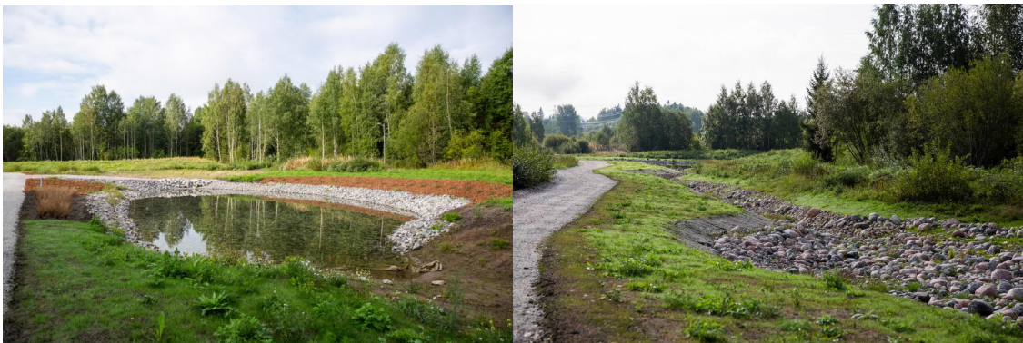
Kuva 3. Valmis Hennalan hulevesien käsittelyjärjestelmä. Vasemmalla laskeutusallas ja oikealla järjestelmän eri osat yhdistävää uomastoa.
