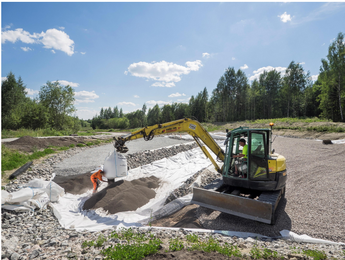
Kuva 4. Biosuodatuskentän täyttövaihetta.
